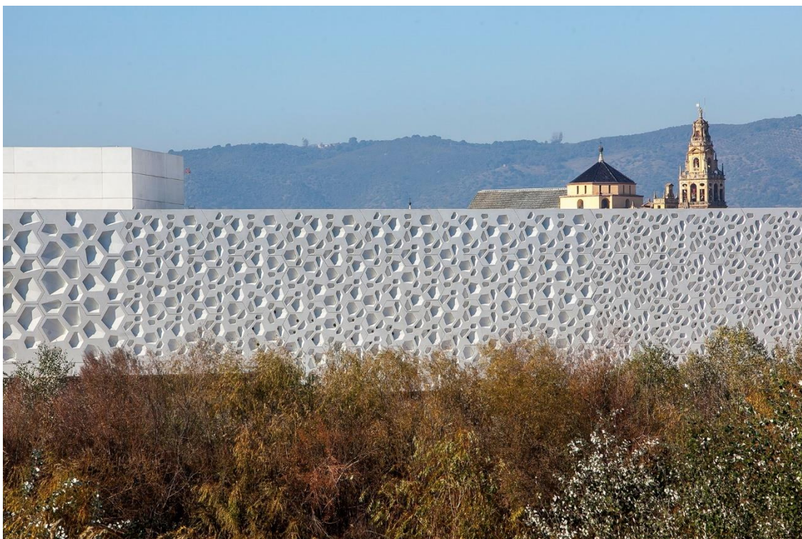
Figura 3.20: Detalle del exterior del C3A
