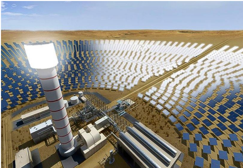
Figura 2.13 - Modelo de Torre Solar de Concentración
