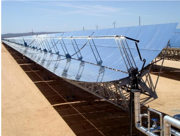
Figura 2.10 – Concentrador Cilindro-Parabólico
