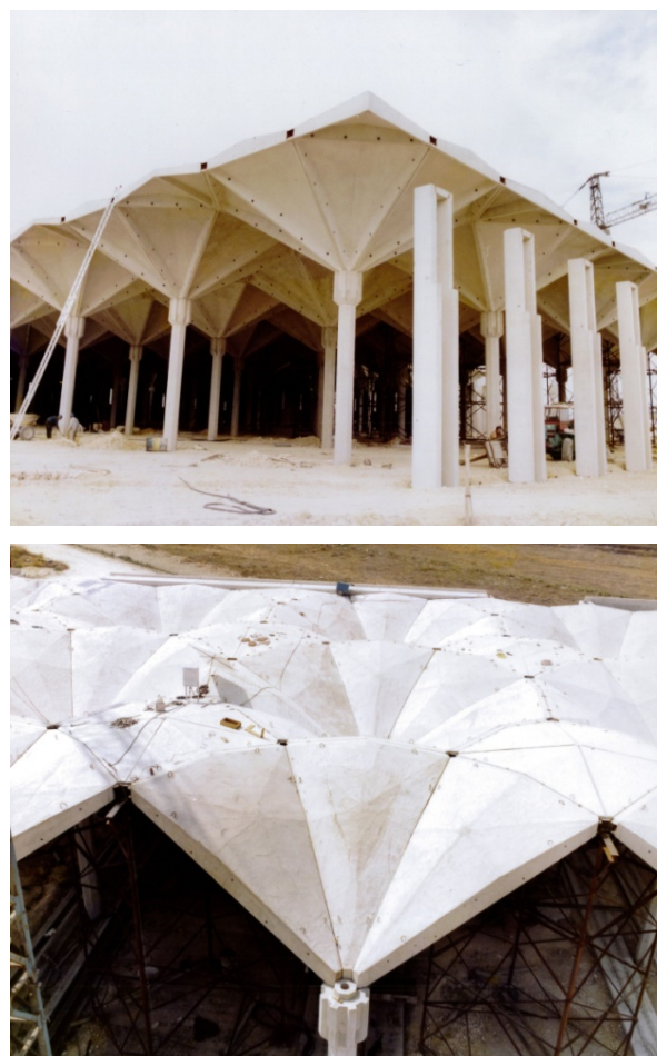
Figura 11: Bodegas Internacionales, proceso de construcción, 1970-72
