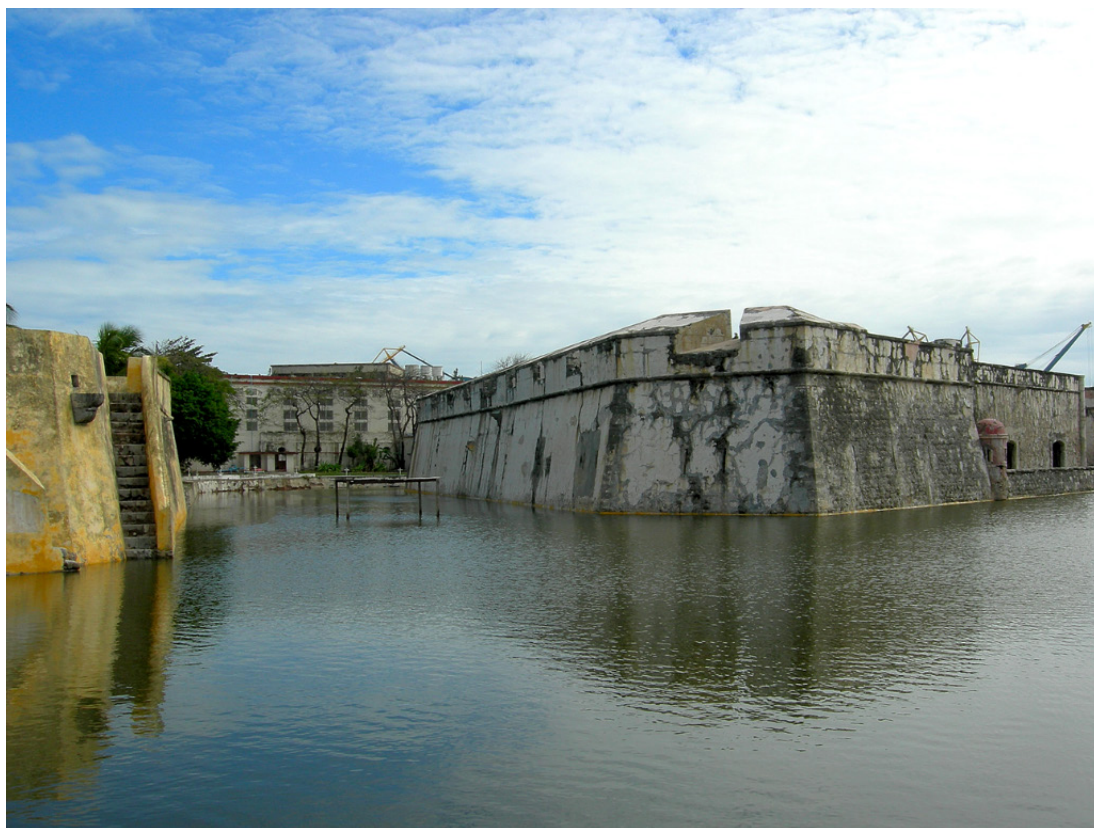
Figura 2. Estado actual del revellín del frente de la Gallega. Castillo de San Juan de Ulúa, Veracruz. Fotografía de Alfredo J. Morales
