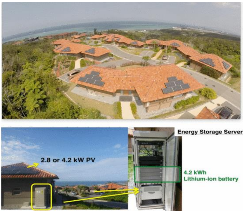
Figura 10: Sistema de energía abierta en CC en el campus de OIST [30]
