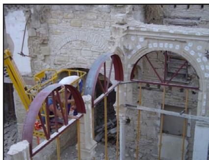
Figuras 1 y 2: Excavación y desmonte de arquería
