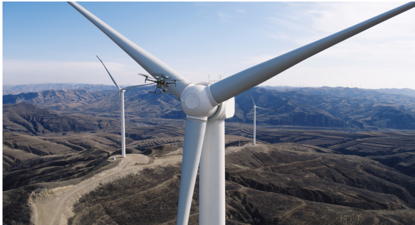
Figura 1.5 Aplicación de un dron en inspección de infraestructuras.
