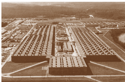
K 25 (Oak Ridge, Tennessee). Difusión fraccionada UF_6 (g). (edificio de cuatro plantas, ~400 m largo y 30 m ancho)
