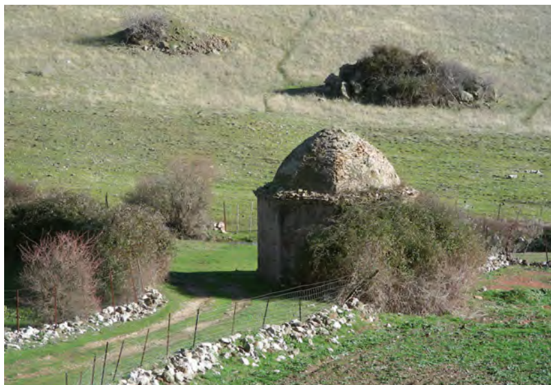
Figura 12. Lumbrera para aireación del acueducto de Villaluenga del Rosario. (Fotografía del autor)
