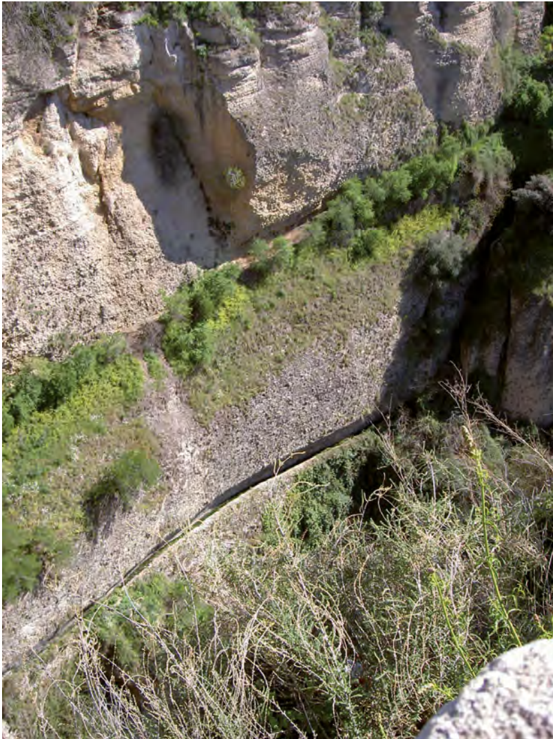
Figura 10. Acequia tallada en la margen izquierda del Tajo de Ronda. (Fotografía del autor)
