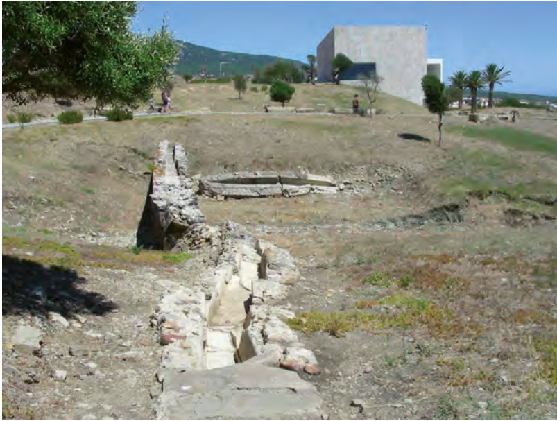
Figura 1. Acueducto de Punta Paloma, perteneciente a la antigua Baelo Claudia . Las arquerías salvan el arroyo del Chorrera poco antes de alcanzar la muralla de la ciudad romana. (Fotografía del autor)
