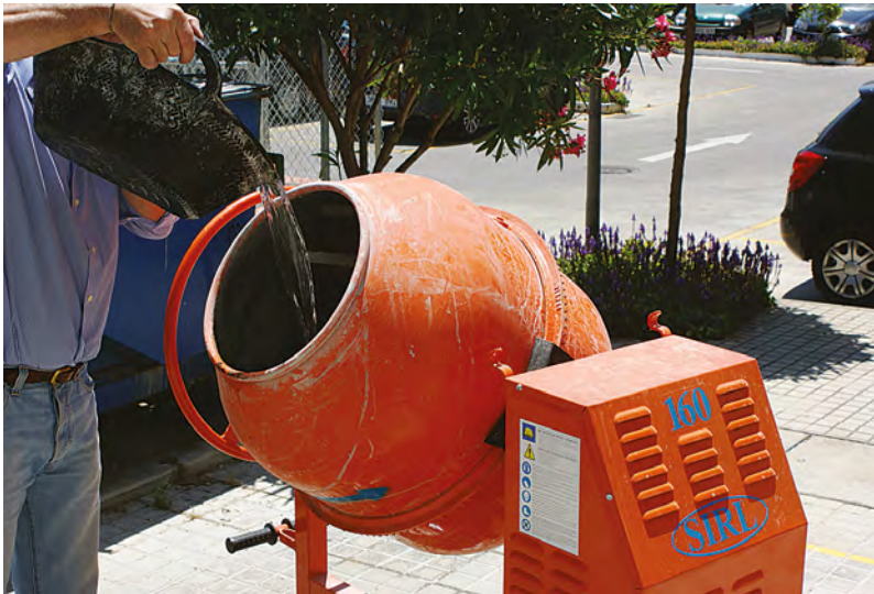
Imagen 5. Vertido de agua en una amasadora de hormigón.
