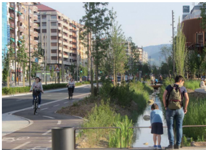
Figura 10. Vista de un curso fluvial desaterrado en la avenida Gasteiz
