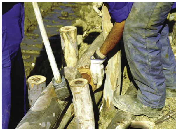
Figura 7. Instalación de empalizada de madera para estabilización de taludes (arriba) y esquema de la técnica (abajo)
