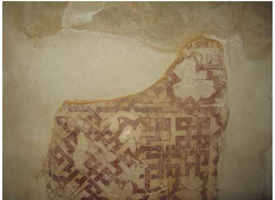
Figura 34 y 35. Imagen general del fragmento de pintura mural del interior de la alcoba, donde se aprecia la humedad en el muro, y detalle de las acumulaciones de jabelga ocre. (Rocío Campos)
