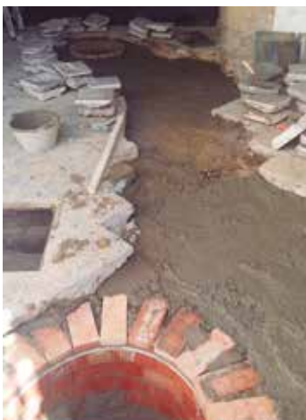
Figura 28. Trabajos de reparación de saneamiento en la Puerta del León tras la aparición de un atasco con reparación de pozos y arquetas, así como sustitución de canalizaciones existentes.
