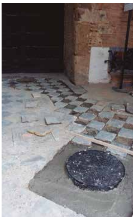
Figura 29. Trabajos de recolocación de solería en Puerta del León tras la reparación del saneamiento. (Juan Manuel Macías)
