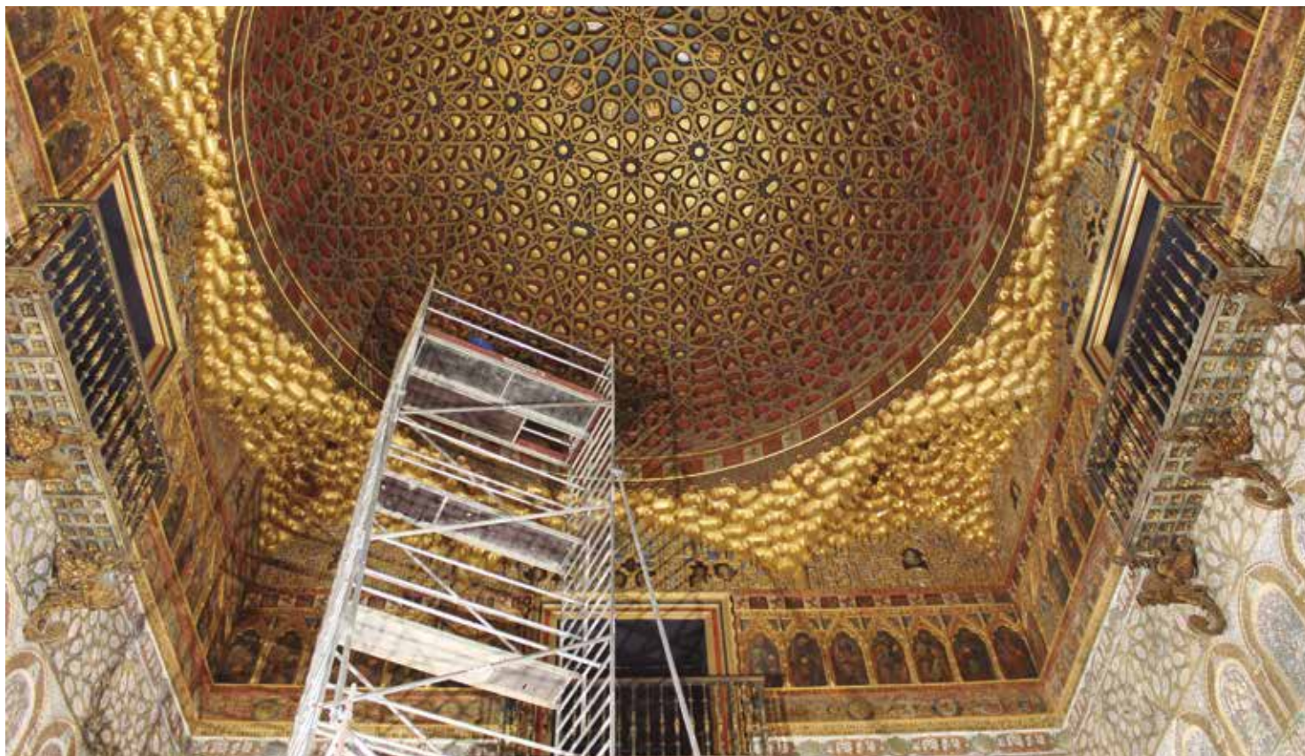
Figura 42. Torre móvil instalada, por la empresa adjudicataria de la actuación de urgencia de mantenimiento, para la limpieza y retirada de las acumulaciones para la formación de nidos. (Cinta Martín)
