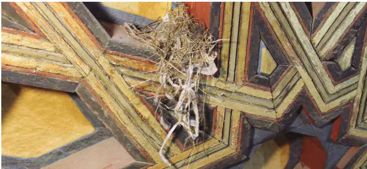
Figura 41. Material vegetal e incluso fibras de fregona para la formación del nido en uno de los casetones de la bóveda de la Media Naranja. (Cinta Martín)
