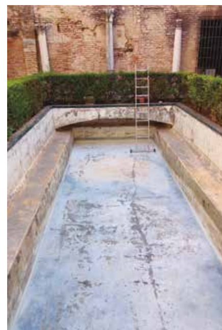
Figura 31. Vaciado del estanque del Patio del Yeso para la reparación de fugas de agua. (Juan Manuel Macías)
