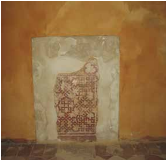
Figura 34 y 35. Imagen general del fragmento de pintura mural del interior de la alcoba, donde se aprecia la humedad en el muro, y detalle de las acumulaciones de jabelga ocre. (Rocío Campos)
