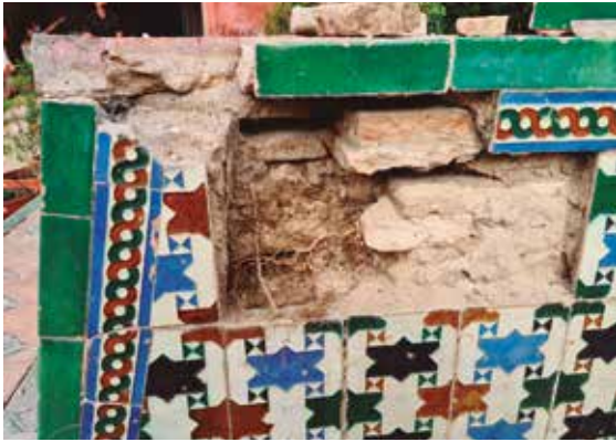
Figura 25. Lateral del banco noreste, raíces creciendo entre la fábrica. (José Manuel Gavira)
