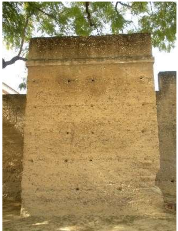
Fotografía 47: Torre de tapial común de módulo alto.
