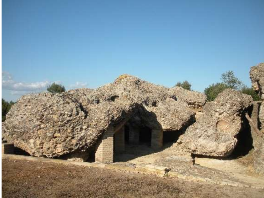
Fotografía 28: Restos de Exedra ejecutada en opus caementicium
