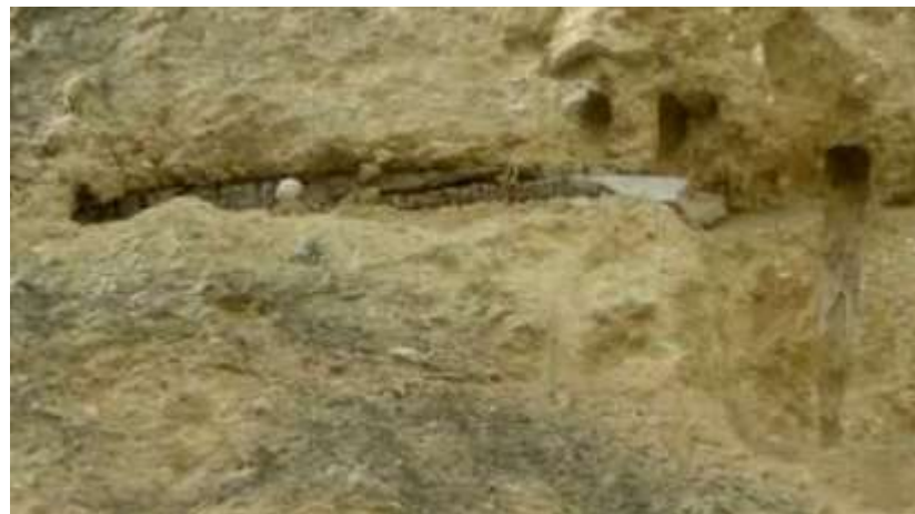
Imagen 34: Resto de aguja e impronta de los clavos. Muralla de Sanlúcar la Mayor (Sevilla). (Imagen J. Canivell)
