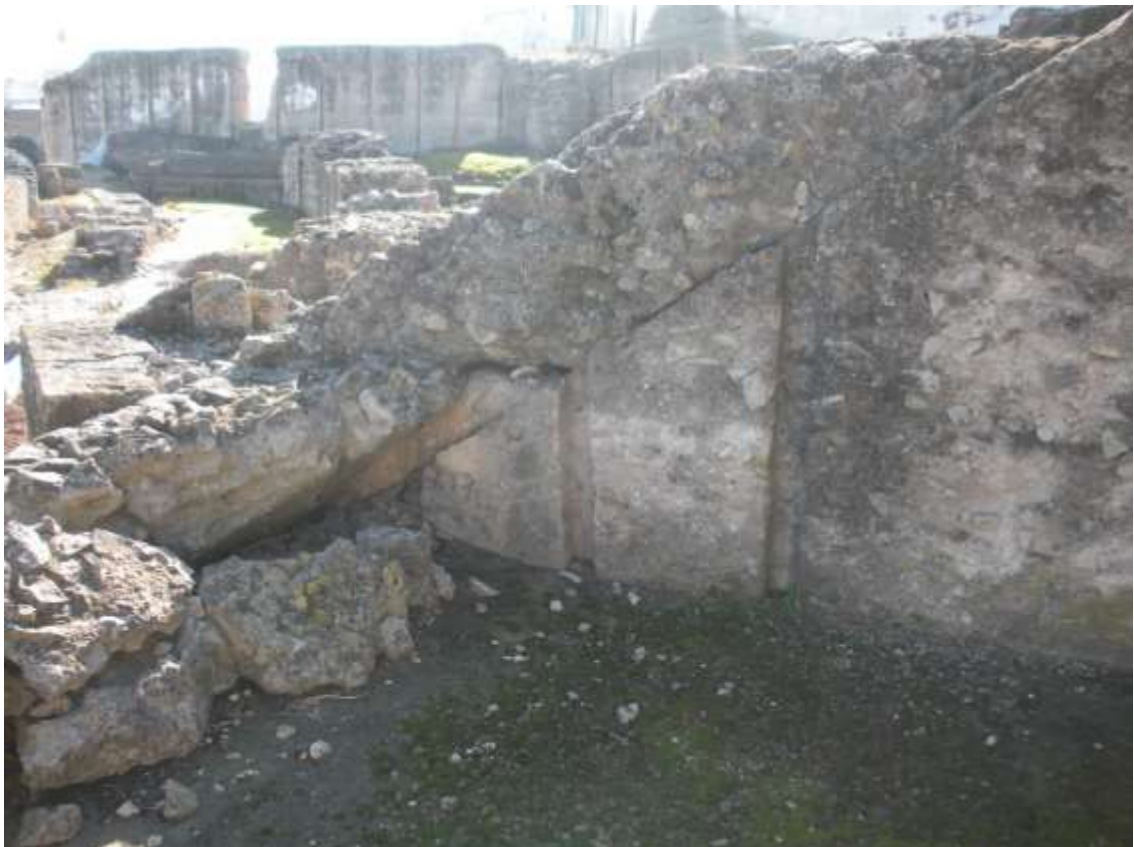
Fotografía 7: Detalle de disposición de losas sobre contrafuertes del muro superior occidental.
