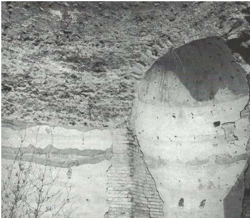
Imagen 22: Detalle de la Cúpula de opus caementicium de las termas del Centro en Pompeya. (Imagen 442 en Adam (2002:199)).
