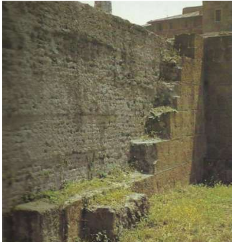
Imagen19: Detalle de opus caementicium que rellenaba el interior de un muro de sillares de piedra en el Foro romano (Roma). (Imagen 11 en Lamprecht (1985:23)).
