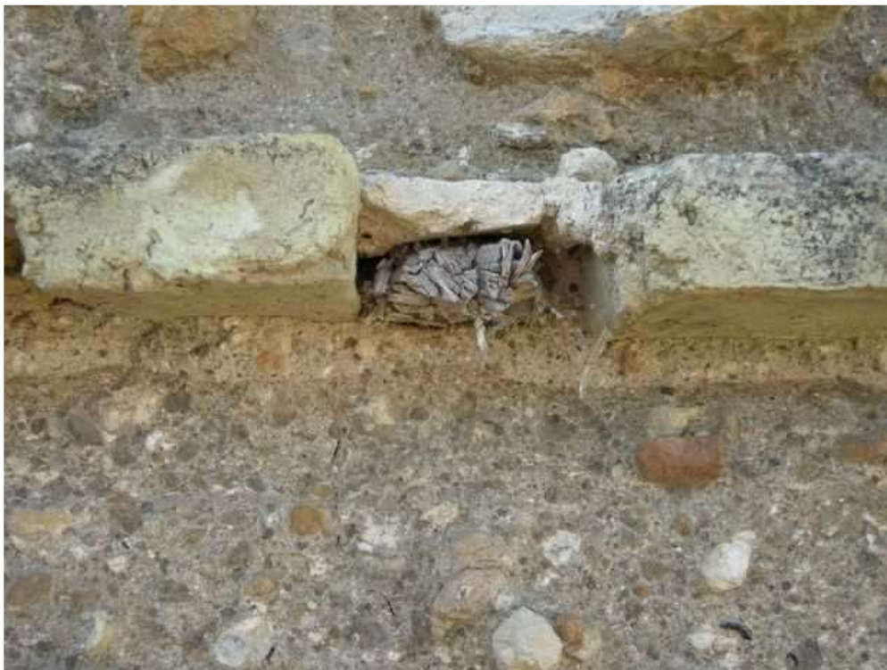
Imagen 30: Aguja entre verdugada de ladrillo y con remate late ricio. Muralla de Marchena (Sevilla) (Imagen de J. Canadell).
