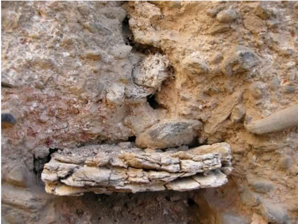
Imagen 31: Aguja e impronta de la cuerda. Muralla de Granada (Imagen J. Canivell).
