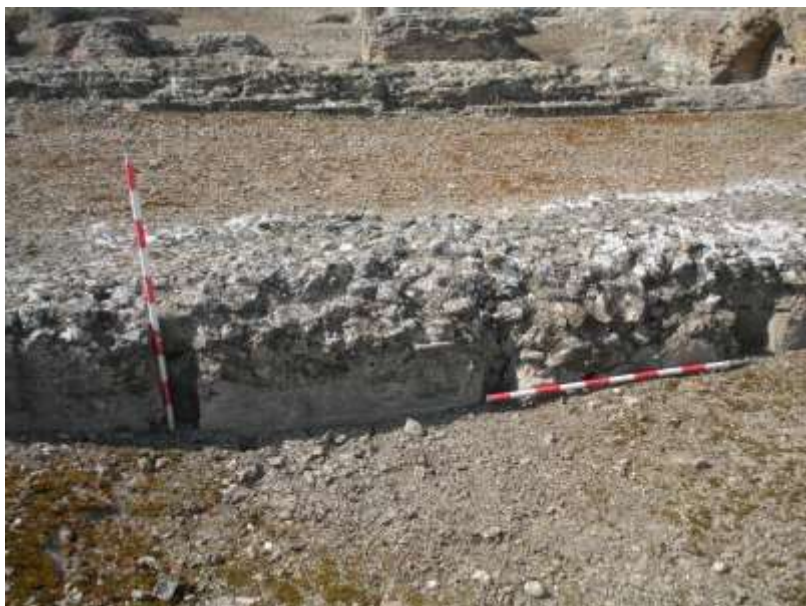
Fotografías 30 y 31: Restos de cimentación de opus caementicium apisonado ejecutado con encofrados de madera en área de baños.
