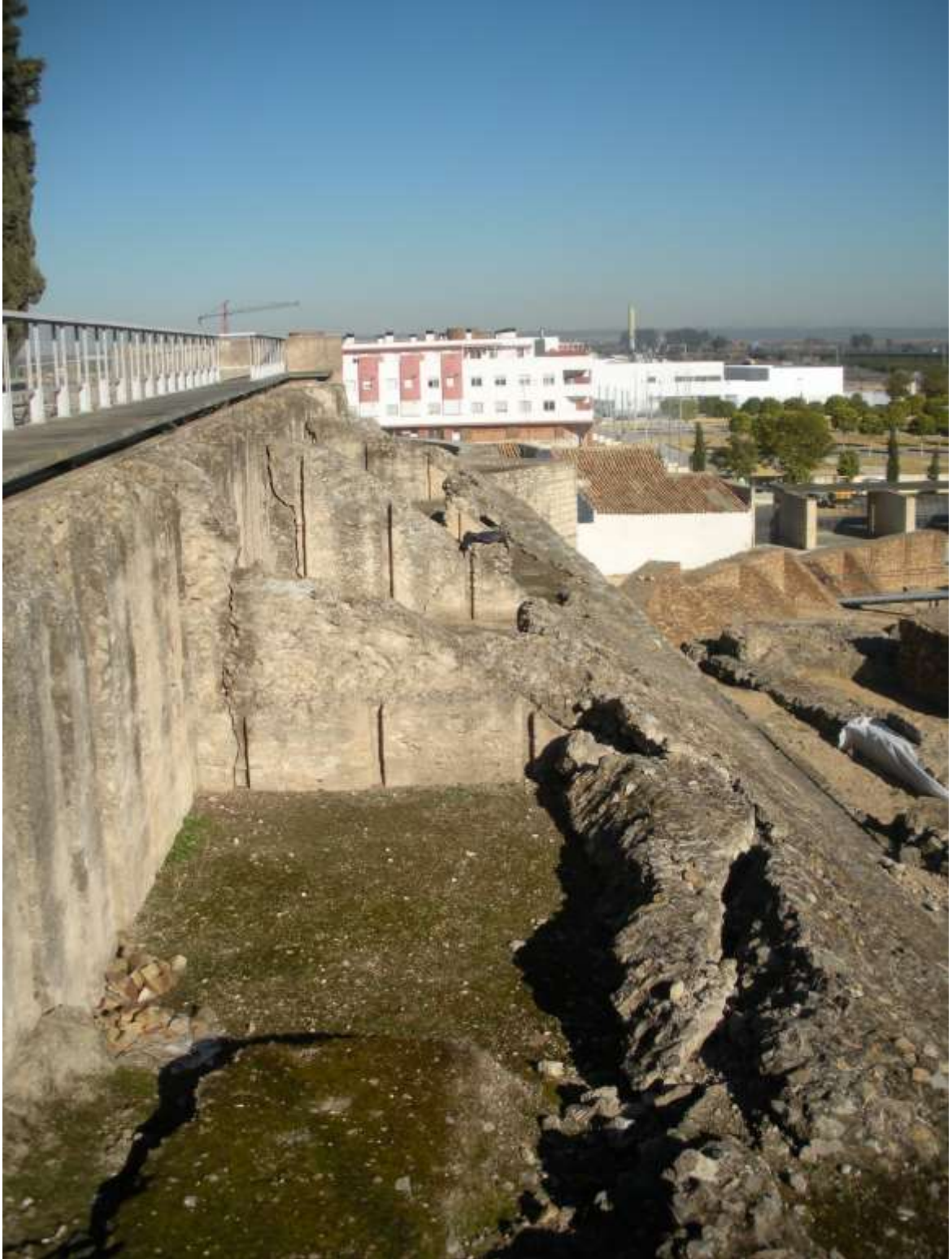
Fotografía 6: Vista general del muro superior occidental, contrafuertes y resto de losas del aterrazamiento
