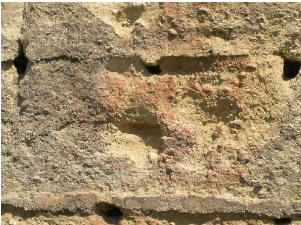
Fotografía 57: Mechinales de agujas planas en torres.
