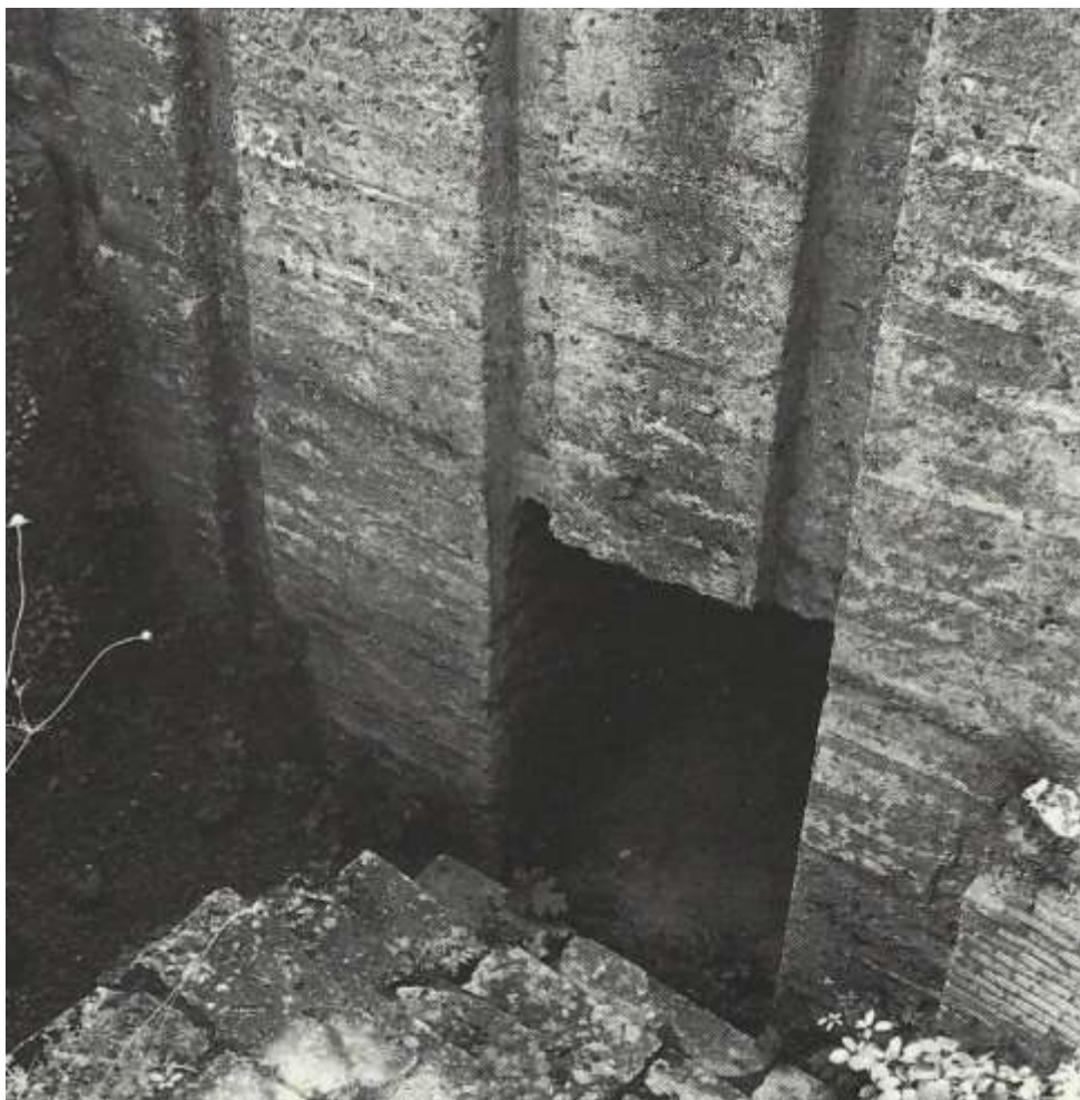
Imagen18: Detalle de las huellas de los postes y tableros de encofrados empleados en la cimentación del Palatino (Roma). (Imagen 13 en Lamprecht (1985:24)).
