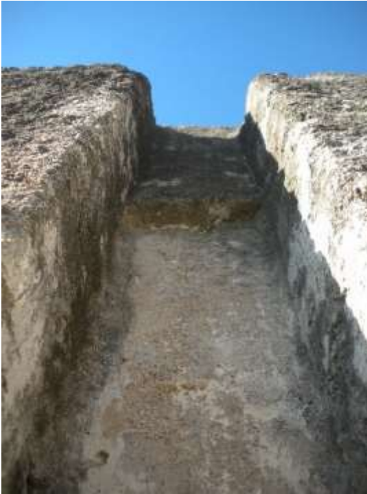
Fotografías 10 y 11: Huellas que definen la longitud de los costales.
