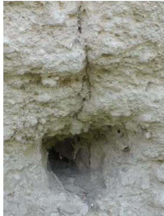
Fotografías 54 y 55: Improntas de la cuerda de acodamiento.
