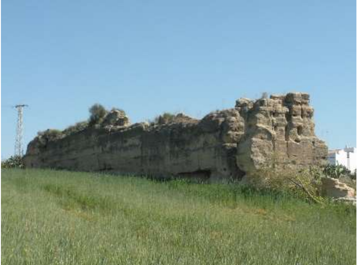
Fotografía 52: Restos de lienzos de la Muralla urbana de Sanlúcar la Mayor.
