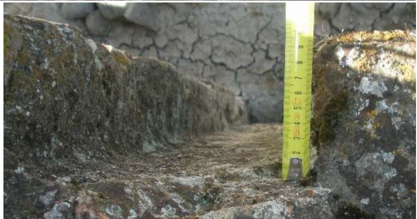
Fotografías 23 y 24: Medición de las huellas del encofrado empleado en las cimentaciones. Medidas más empleadas de 18x11cm.
