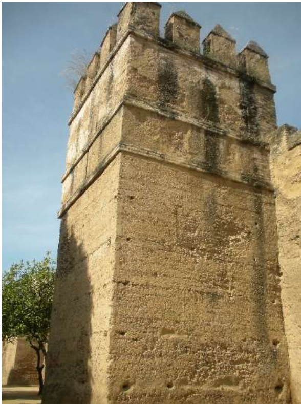
Fotografías 81 y 82: Torres de la Muralla del Valle y Macarena de tapial verdugado de ladrillo
