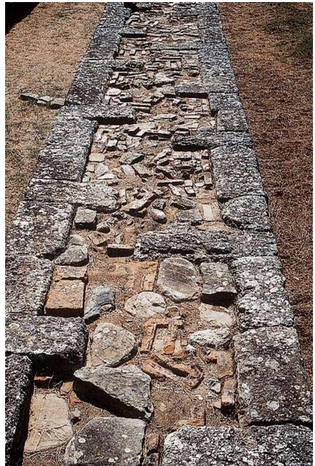
Imagen 2: Detalle de un muro realizado con la técnica de emplecton en la ciudad de Velia (Turquía). (Foto de A. Acocella 7 ).
