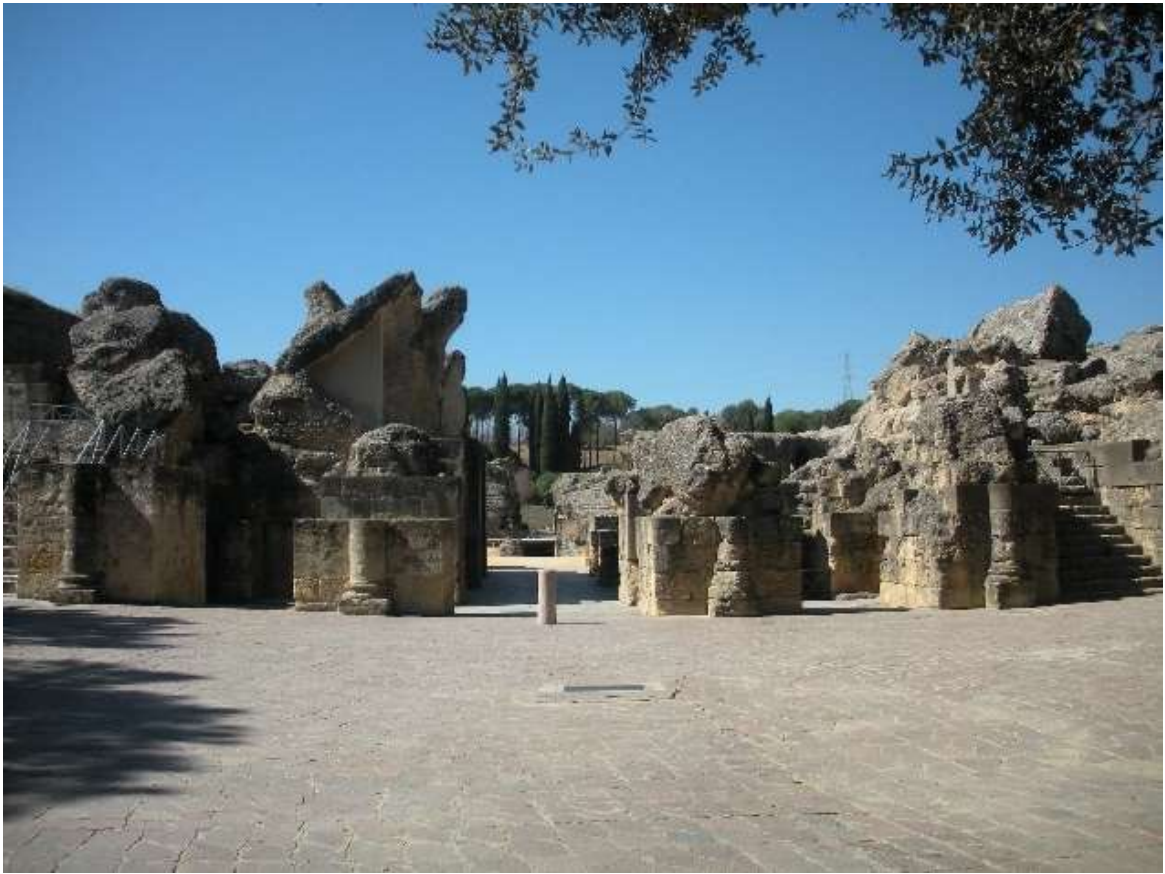
Fotografía 36: Vista de la fachada principal del Anfiteatro orientada al Este.
