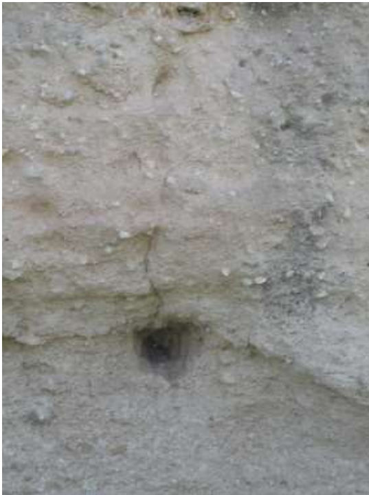
Fotografías 54 y 55: Improntas de la cuerda de acodamiento.
