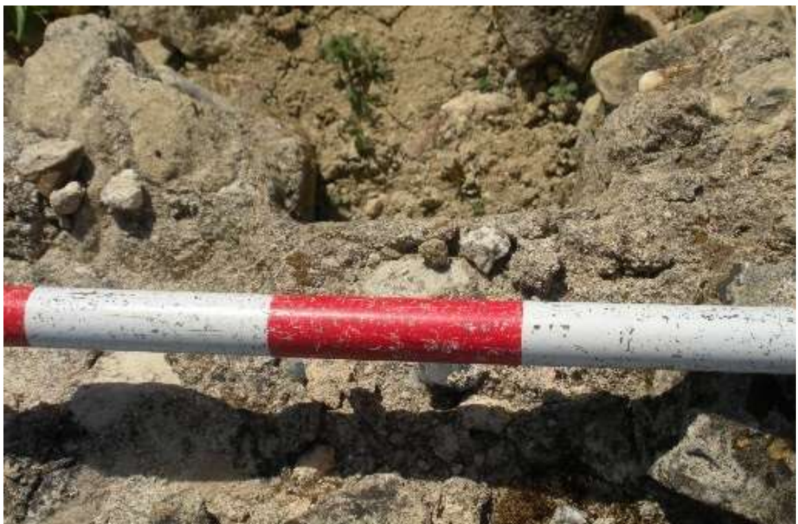
Fotografías 17 y 18: Restos de cimentación de opus caementicium apisonado ejecutado con encofrados de madera en la zona de las Exedras del Traianeum.
