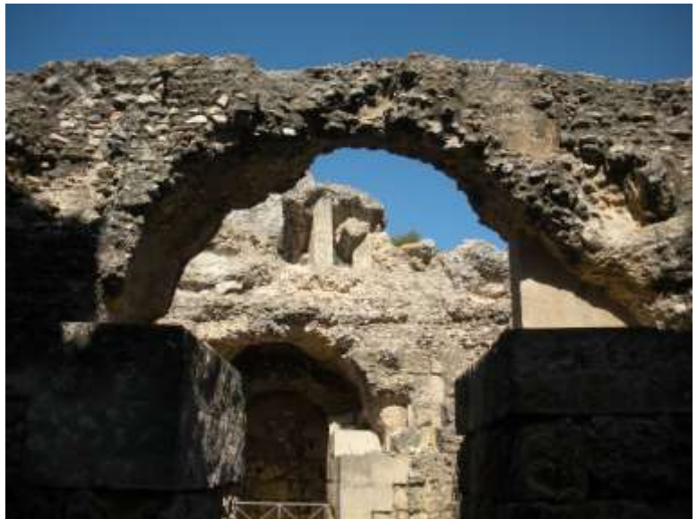
Fotografía 84: Vista de distintos elementos constructivos (muros, arcos y bóvedas) del Anfiteatro de Itálica ejecutados con opus caementicium .
