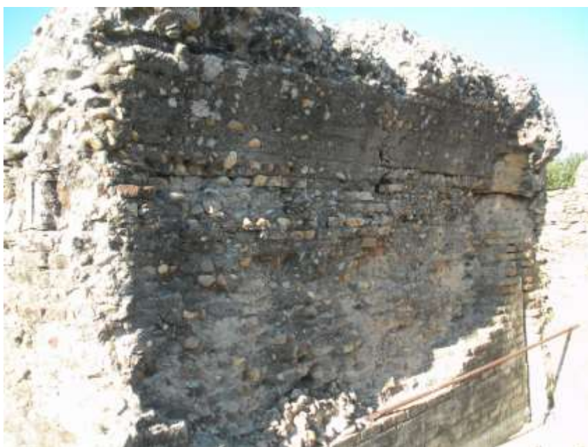
Fotografía 29: Muro de la Exedra encofrado con ladrillos
