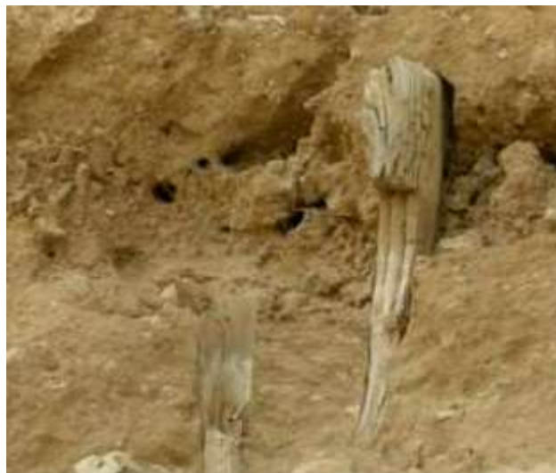
Imagen 33: Restos de clavos. Muralla de Sanlúcar la Mayor (Sevilla). (Imagen de J. Canivell).
