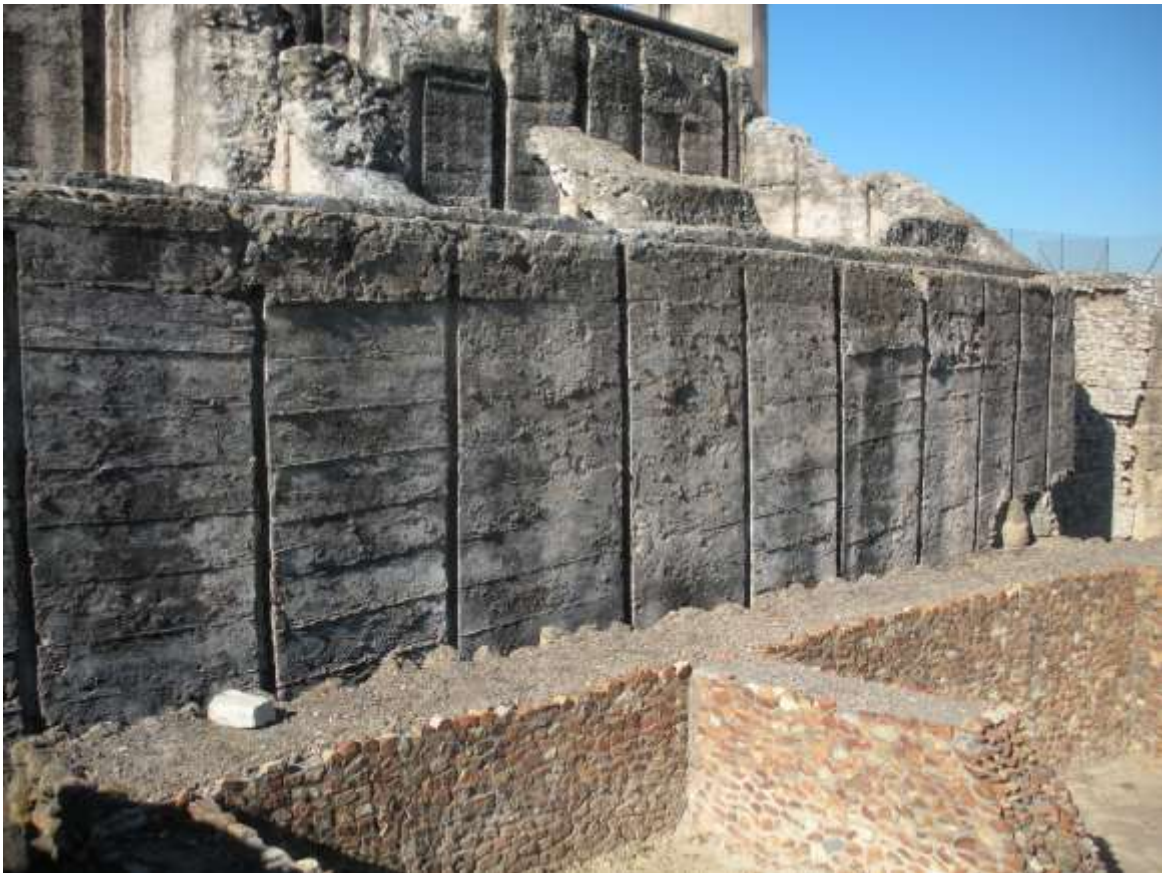
Fotografía 8: Vista de Conjunto de muros inferior, superior, contrafuertes y losas
