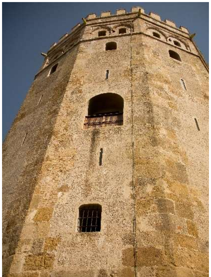
Fotografía 83: Torre del Oro de tapial encadenado de sillares pétreos en cuerpo inferior combinado con tapial verdugado de ladrillo.
