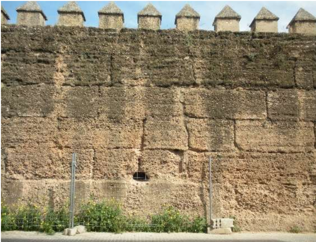
Fotografías 65: Tapia acerada con grava en tramos de la Muralla Almohade de Sevilla -Muralla de la Macarena-.
