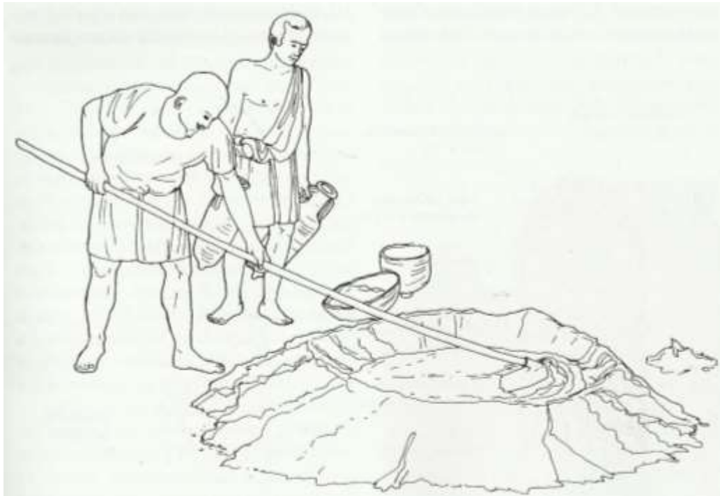
Imagen 6: Detalle de operario preparando el mortero de cal o argamasa. (Imagen 163 en Adam (2002:79)).
