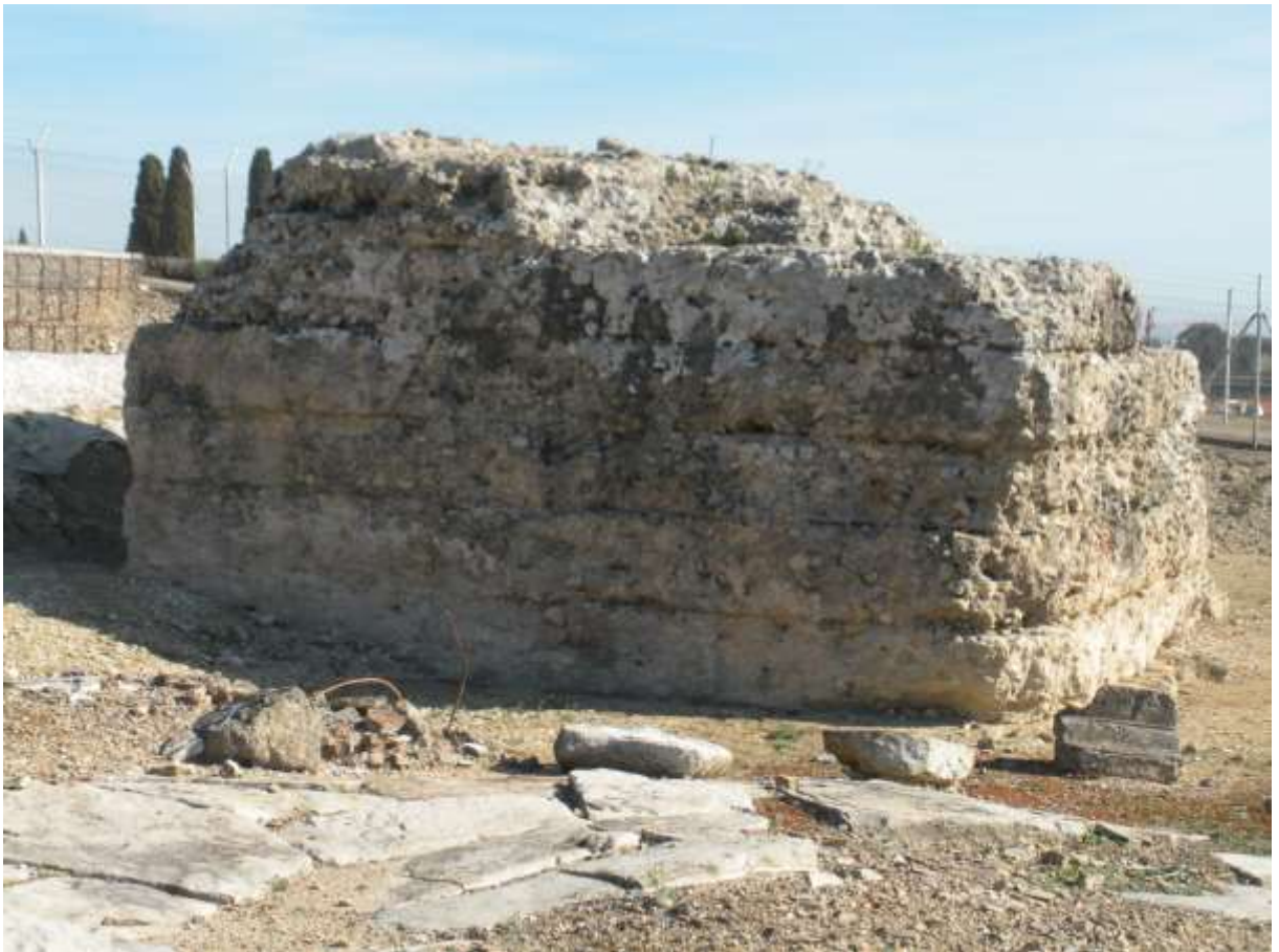
Fotografía 16: Macizo de opus caementicium apisonado donde se observan las huellas del encofrado permanente mediante sillares.
