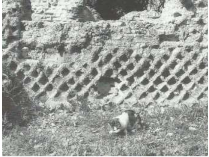
Imagen 21: Opus reticulatum (Imagen fig 310 en Adam (2002:145)).
