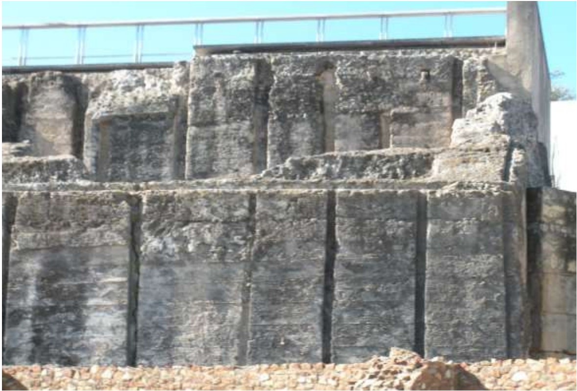
Fotografía 13: Diferencia de escuadría entre los costales de los muros superiores e inferiores.
