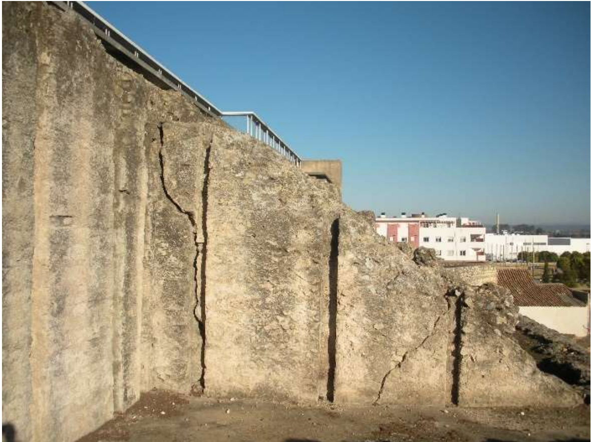
Fotografía 14: Adosamiento de contrafuertes al muro superior occidental
