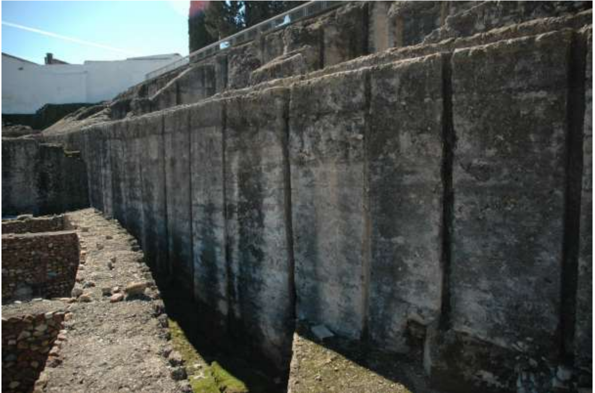
Fotografía 3: Vista de muros, contrafuertes y restos de las losas de la terraza superior del Cerro de San Antonio.
