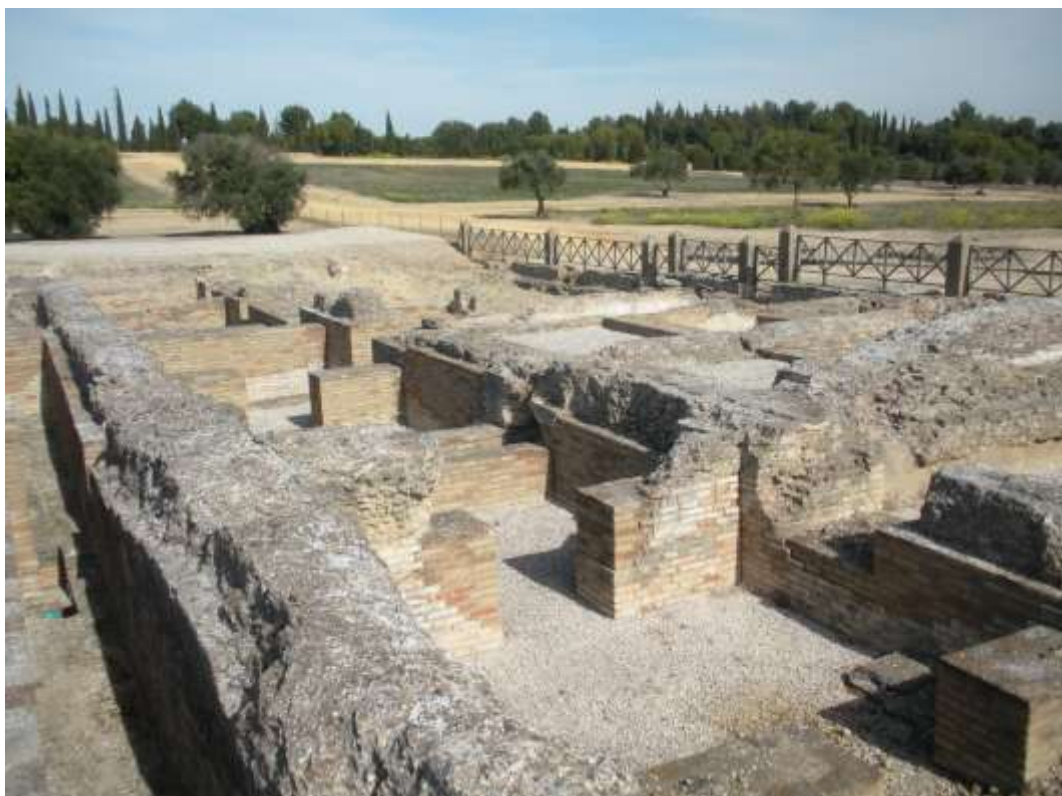
Fotografía 32 y 33: Muros de las estancias realizados mediante opus caementicium encofrados con ladrillo.
