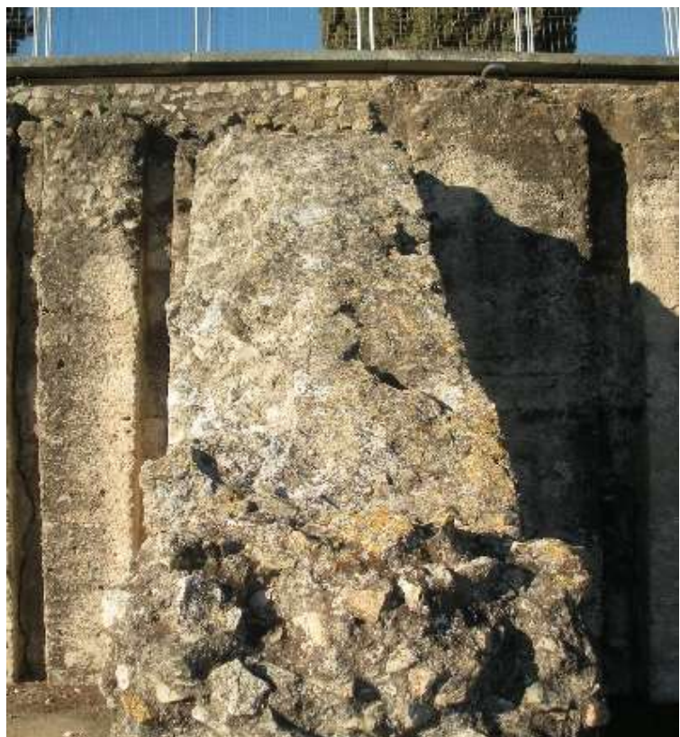
Fotografía 68: Contrafuertes del muro superior occidental del Cerro de San Antonio-Teatro.
