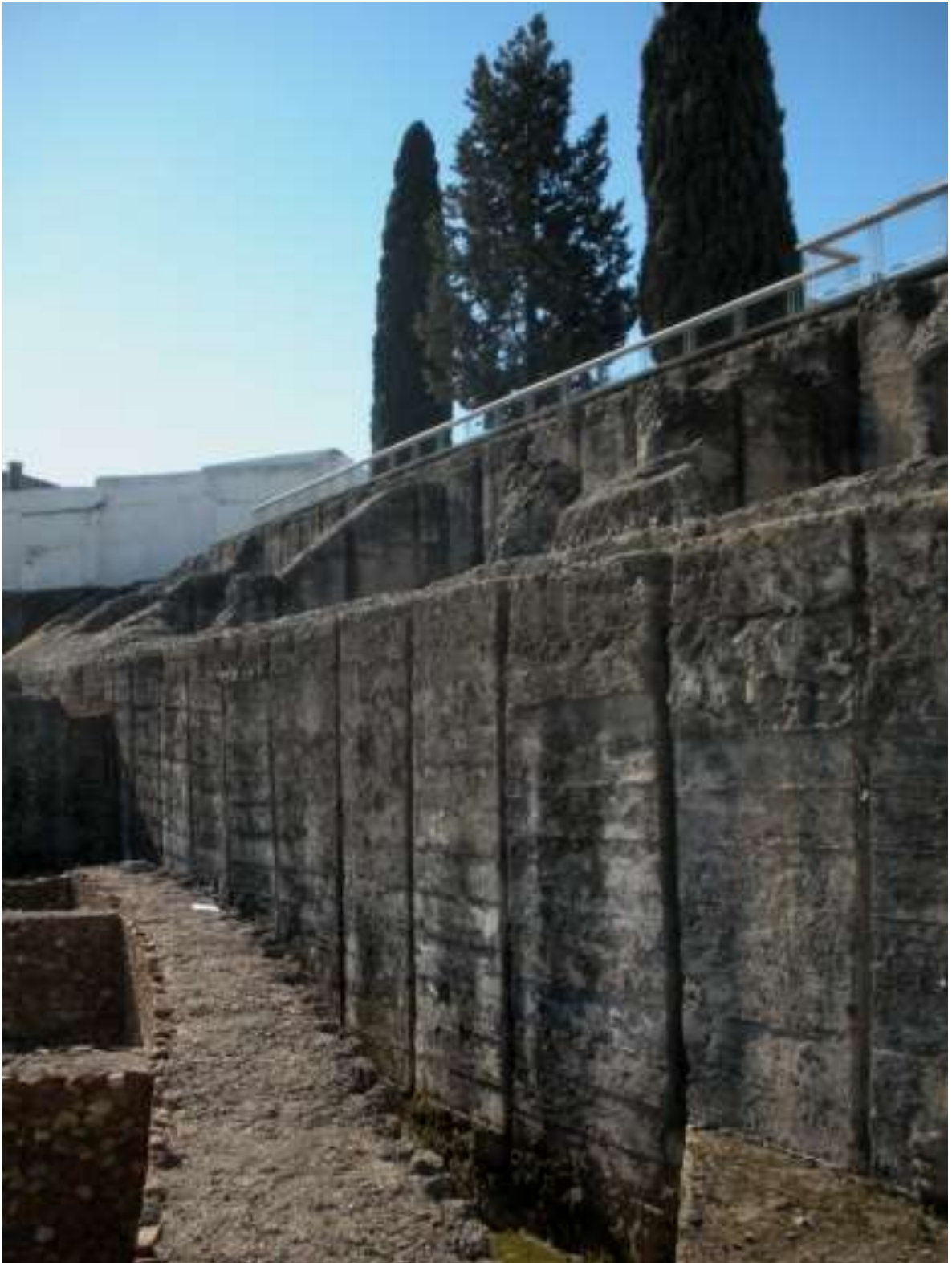
Fotografía 5: Envergadura de los muros inferiores de contención del Cerro de San Antonio.
