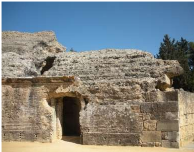
Fotografía 39 y 40: Masas de opus caementicium en muros de gradas que fueron encofrados con sillares o con ladrillos.
