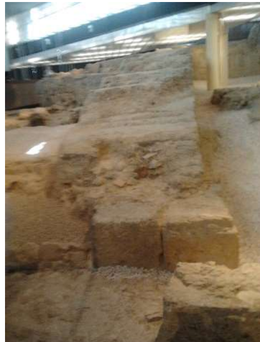
Fotografías 66 y 67: Tapia acerada con grava en tramos de la Muralla Almohade de Sanlúcar la Mayor y San Juan de Aznalfarache.
