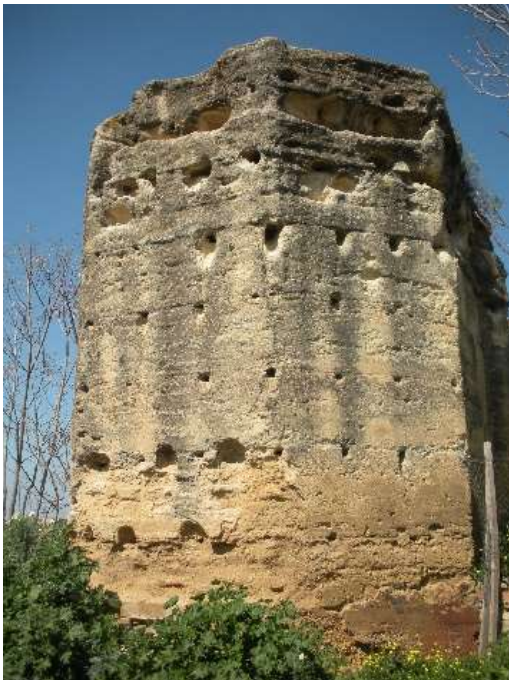
Fotografías 66 y 67: Tapia acerada con grava en tramos de la Muralla Almohade de Sanlúcar la Mayor y San Juan de Aznalfarache.
