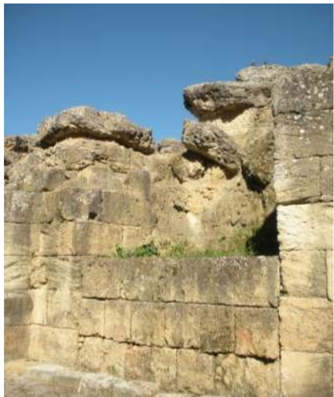
Fotografía 38: Muros de gradas realizados con encofrado permanente de sillares. (Imagen de la autora).
