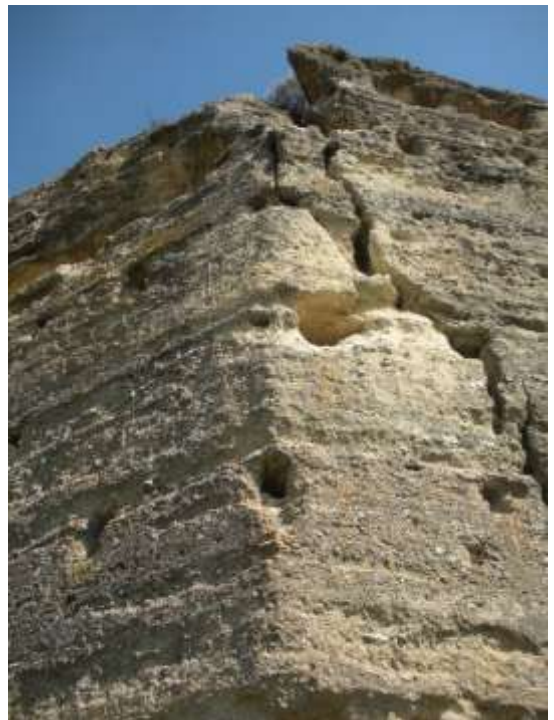
Fotografía 85: Detalle de torre del recinto amurallado de Sanlúcar la Mayor (Sevilla) ejecutados con tapial
