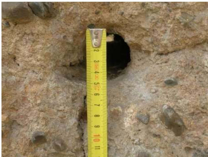
Fotografía 50: Aguja cilíndrica en la barbacana.
