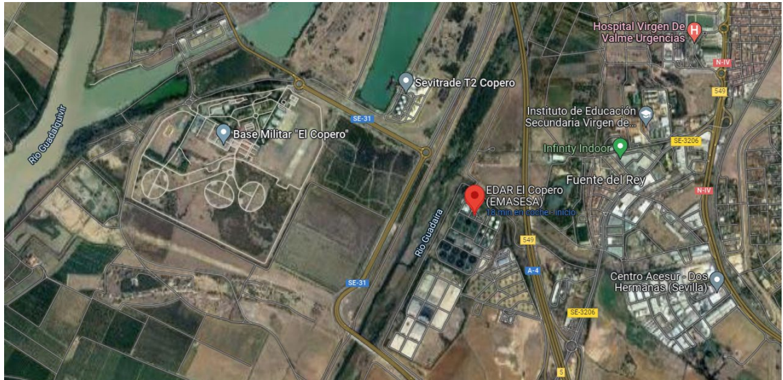
Ilustración 5: EDAR El Copero (Sevilla) Fuente: Google Maps
