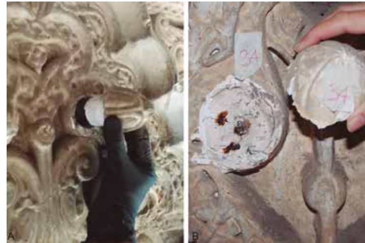
Figura 7. Fijación de las piñas al paño de sebka: A.- Piñas originales del S. XIV y B.- Piñas de reposición posteriores.
