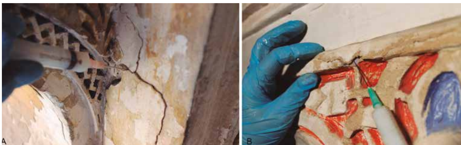
Figura 14. Procedimiento de pegado en yeserías mediante inyección de adhesivo ACRIL AC33. A.- Cara interior sur de la galería del Patio de las Doncellas B) Zona de acceso a la Sala del Cuarto del Príncipe.
