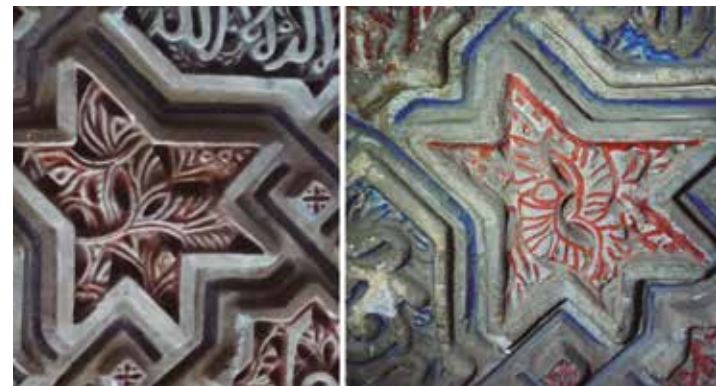
Figura 7. Fijación de las piñas al paño de sebka: A.- Piñas originales del S. XIV y B.- Piñas de reposición posteriores.
