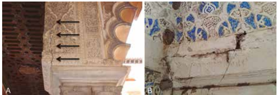
Figura 10. A la izquierda, grieta en esquina sureste del Patio de las Doncellas de hasta 5 mm de abertura en algunos puntos y hasta 14 cm de profundidad. A la derecha, nidos de avispas alfareras en la parte superior de los divanes de Patio de las Doncellas.
