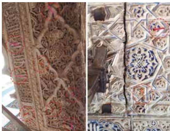
Figura 16. Cosido de placas en la esquina sureste del Patio de las Doncellas con varillas de fibra de vidrio.
