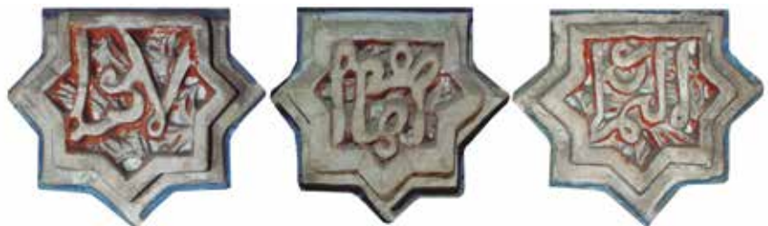
Figura 5. Detalle de elementos tallados en el friso superior de la galería del Patio de las Doncellas. Las epigrafías difieren de unos a otros e incluso encontramos algunas escritas del revés, hechos significativos a la hora de discernir entre talla y molde pues recorriendo las galerías parece una reiteración del mismo elemento a lo largo de todo el perímetro.
