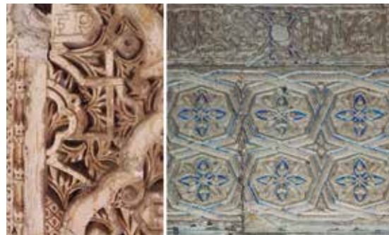
Figura 5. Detalle de elementos tallados en el friso superior de la galería del Patio de las Doncellas. Las epigrafías difieren de unos a otros e incluso encontramos algunas escritas del revés, hechos significativos a la hora de discernir entre talla y molde pues recorriendo las galerías parece una reiteración del mismo elemento a lo largo de todo el perímetro.
