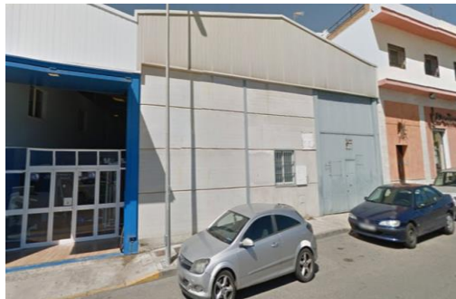
Figura 3.2. Fachada de la clínica.
