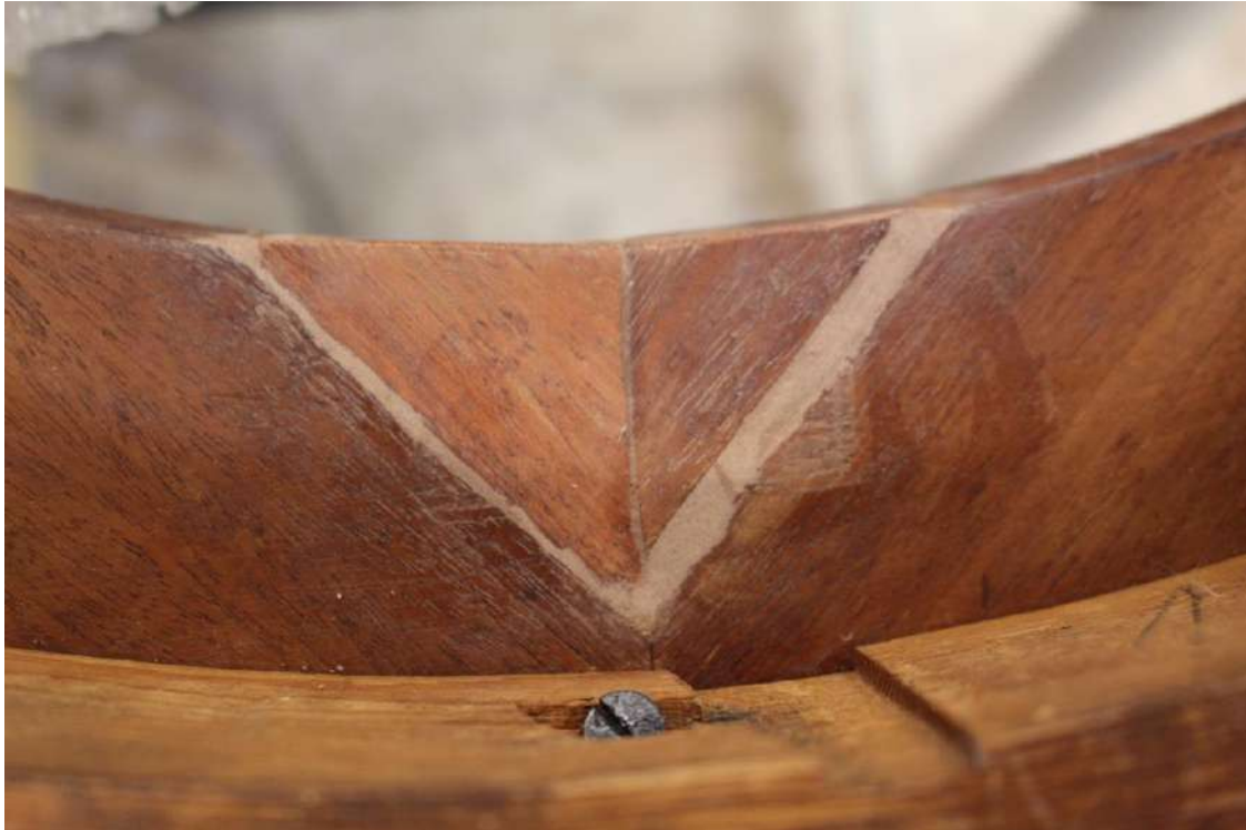
Ilustración 27: Detalle de la reposición de una pieza de madera ya aplicada la resina y enrasado.
