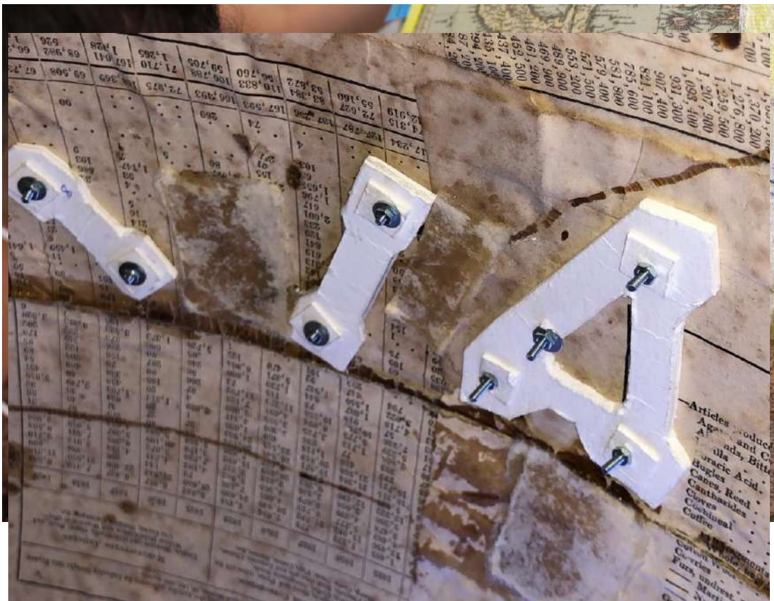
Ilustración 19: Vista de las grapas en el interior. Fuente: Laura Carmona
