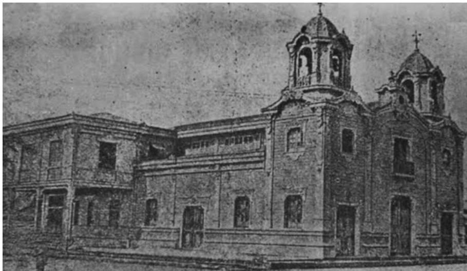
Figura 1. Vista exterior de la iglesia del convento de Tondo (Manila), antes de 1871.
