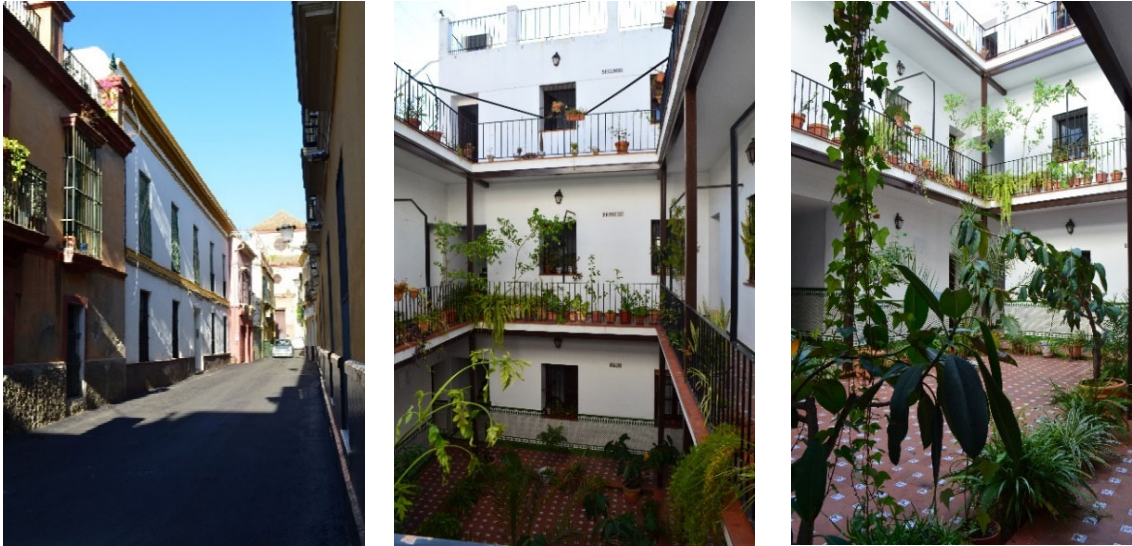
Fig. 41. Tres vistas del edificio caso de estudio. A la izquierda, la fachada con la entrada a la Iglesia de San Gil, al final de la Calle Sagunto. A la derecha, dos imágenes del patio comunitario interior a través del cual se accede a las viviendas.
