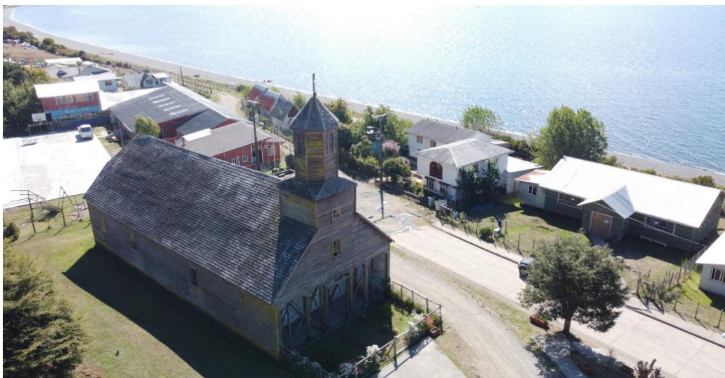
Imagen 7: Iglesia Apostol de Detif. Fuente: Proyecto de intervención patrimonial Iglesia Detif.
