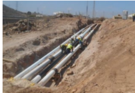
Imagen 1 Zanja abierta. Cedida por empresa del sector.
