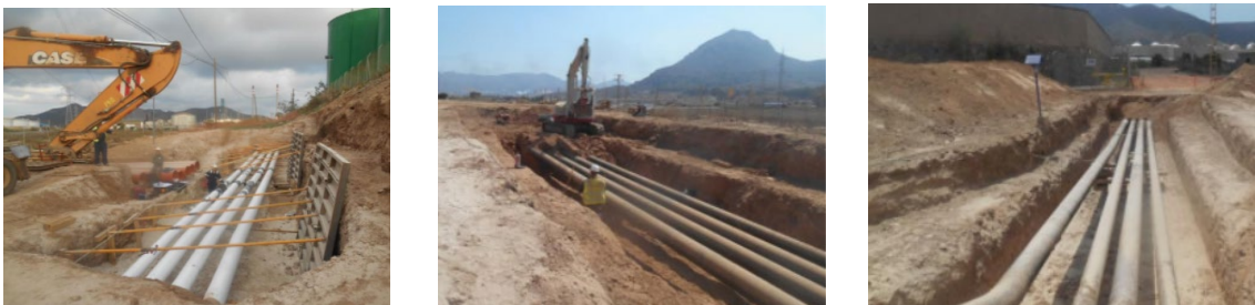
Imagen 26. Zanjas para operar en tuberías. Elaboración propia.
