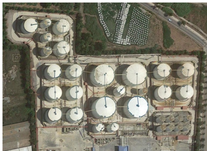
Imagen 14. Instalación de almacenamiento en Motril, Granada, España. Fuente: Google Earth
