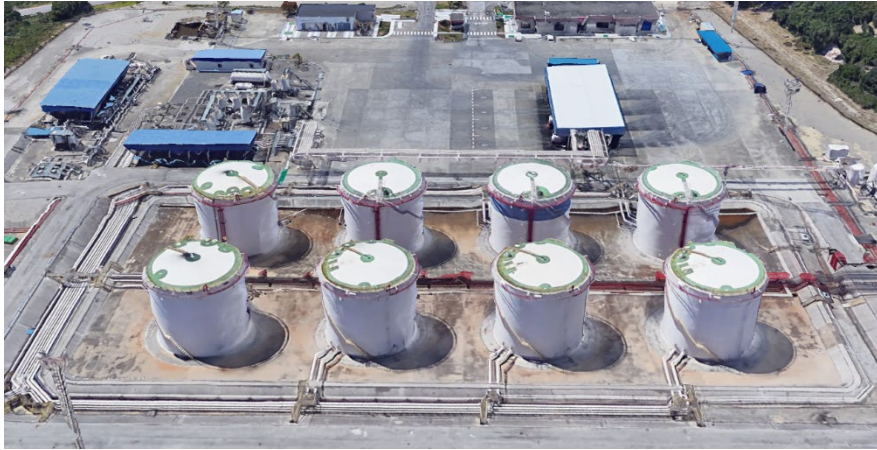
Imagen 17. Instalación de almacenamiento en San Roque, Cádiz, España. Fuente: Google Earth
