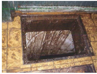
Imagen 9. Arqueta. Fuente: Piñero Piolestán, 2021
