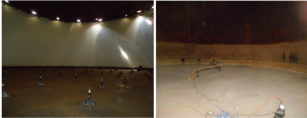
Imagen 38. Interior de un tanque de almacenamiento. Cedidas por empresa del sector.
