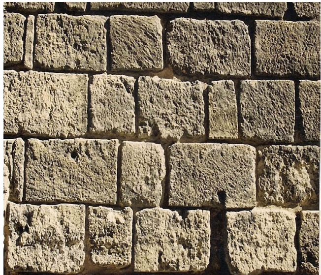
Figura 19. Hiladas de roca calcarenítica, mayoritarias en la construcción del alcázar.
