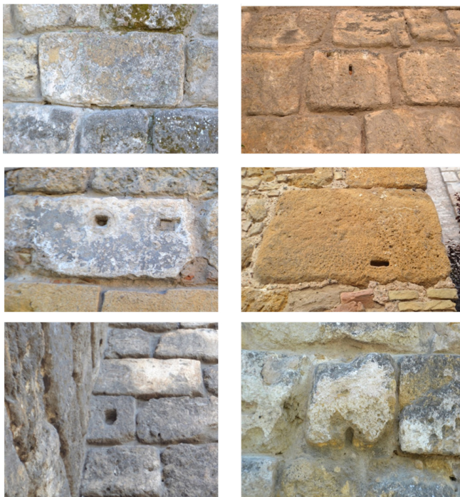
Figura 23. Huellas de acople e izado desorganizadas respecto a la posición actual del bloque, muestra de su reutilización
