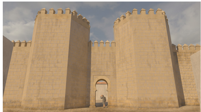
Figura 13. Reconstrucción de la puerta original del primer recinto, hoy bajo la casa 16 del Patio de Banderas. Su fábrica era de tapia encadenada con machos de aparejo mixto. (Recreación de Jesús García)
