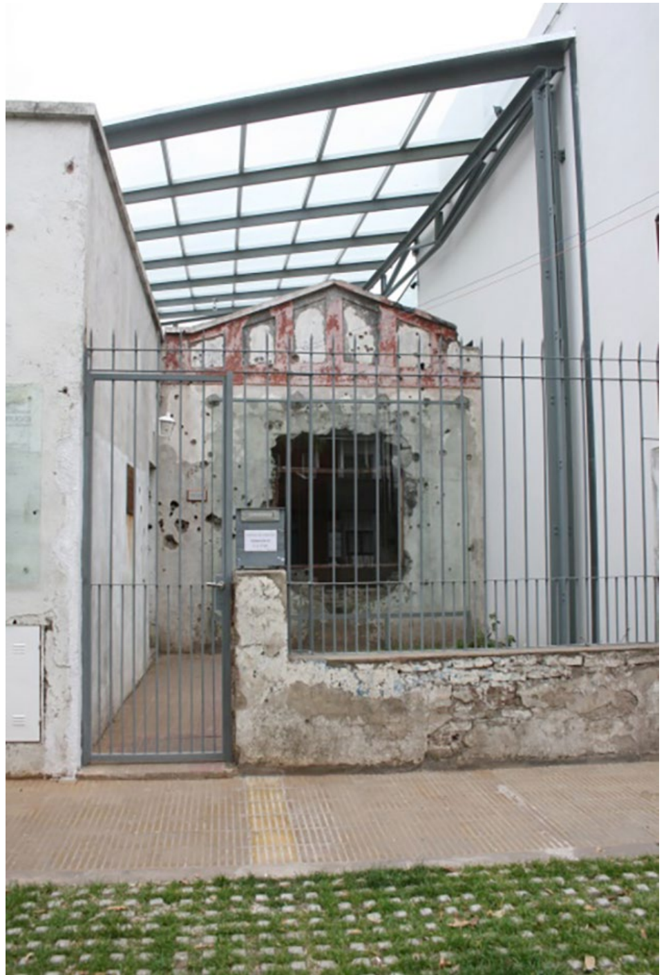
Figura 7. Casa Mariani-Teruggi. A. Ottavianelli / F. Gandolfi. La Plata (Argentina). Fachada a la calle y acceso principal a la casa, vista de la cubierta superpuesta. Pueden apreciarse los efectos del ataque, agujeros de metralla y desperfectos en el hueco de la ventana, musealizados mediante la superposición de un vidrio sobre estructura de acero galvanizado. (Fuente: Marta García-Casasola, 2011).
