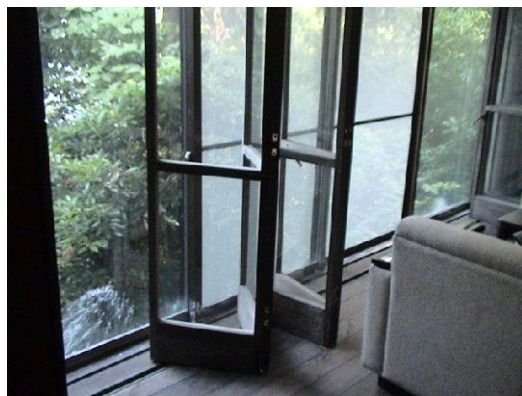
Figura 3. Detalle de la ventana plegable diseñada por Taut en la casa Hyûga de Atami (Japón)
