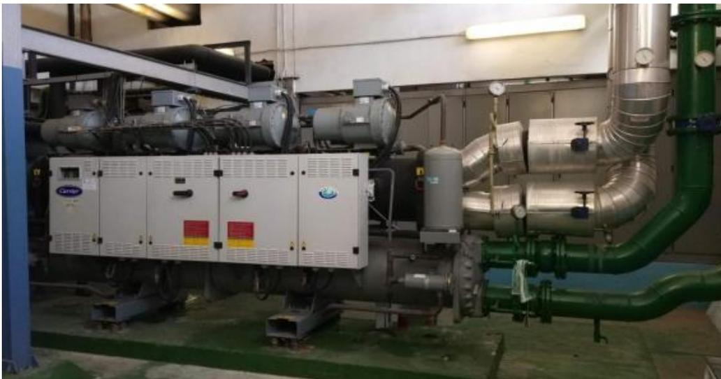
Ilustración 6 - Enfriadora condensada por agua sala técnica HM
