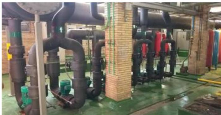
Ilustración 36 – Bombas de circulación circuitos primario y secundario frío planta 1ª HM
