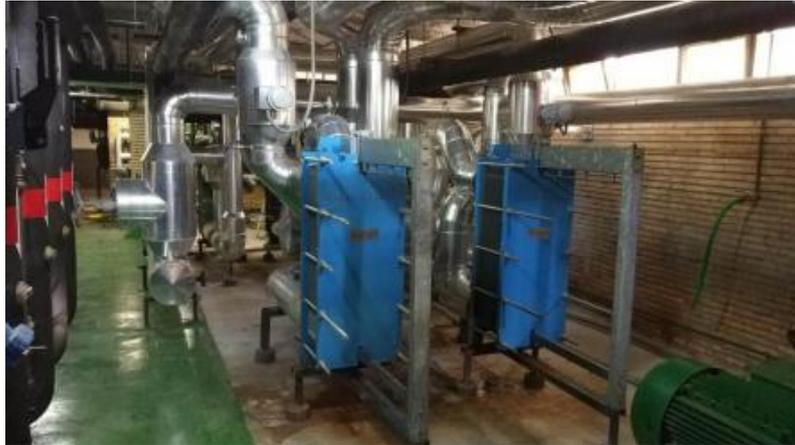
Ilustración 33 - Intercambiadores de calor de placas existentes en el HM y HI
