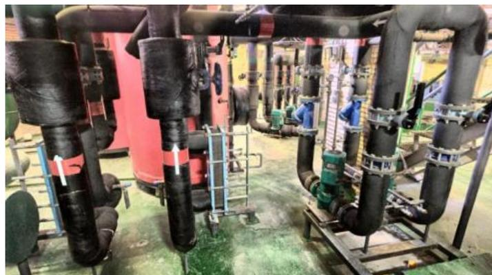
Ilustración 35 - Intercambiadores de calor de placas y bombas circuito primario calor planta 1ª HM
