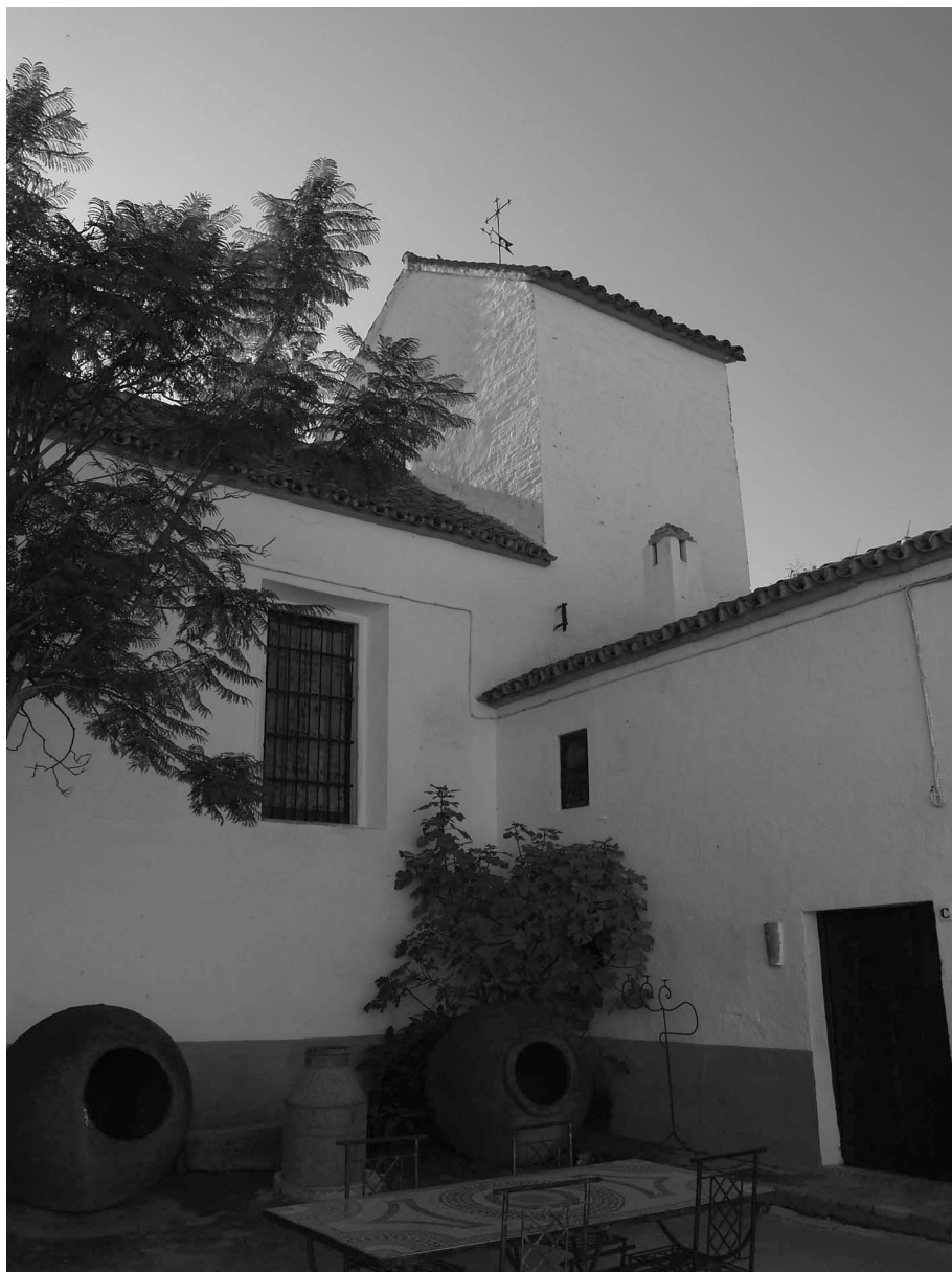
Lám. 10. Torre de contrapeso de la nave de la viga del patio principal, hacienda Los Ángeles, Alcalá de Guadaíra (Sevilla)
