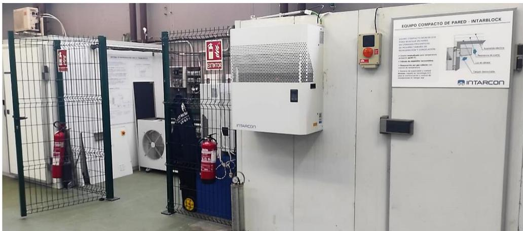
Cada cámara frigorífica alberga en su interior un evaporador y varias resistencias que simulan la carga térmica que tendrían las cámaras frigoríficas, mientras que comparten tanto el gas cooler como el compresor. De esta manera, las resistencias pueden ser de 0,5 kW, 1 kW, 1,5 kW, 2 kW o 2,5 kW en cada cámara frigorífica. En la figura 6 se muestran los elementos mencionados, además del tanque flash.
