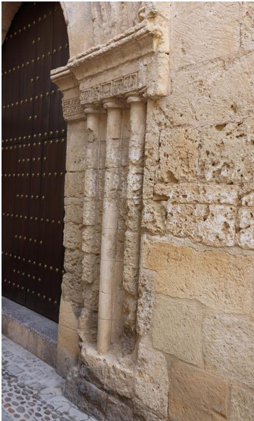
Figura 9. Santiago: integración de la portada principal en hastial con engatillados en jamba derecha (fotografía del autor).
