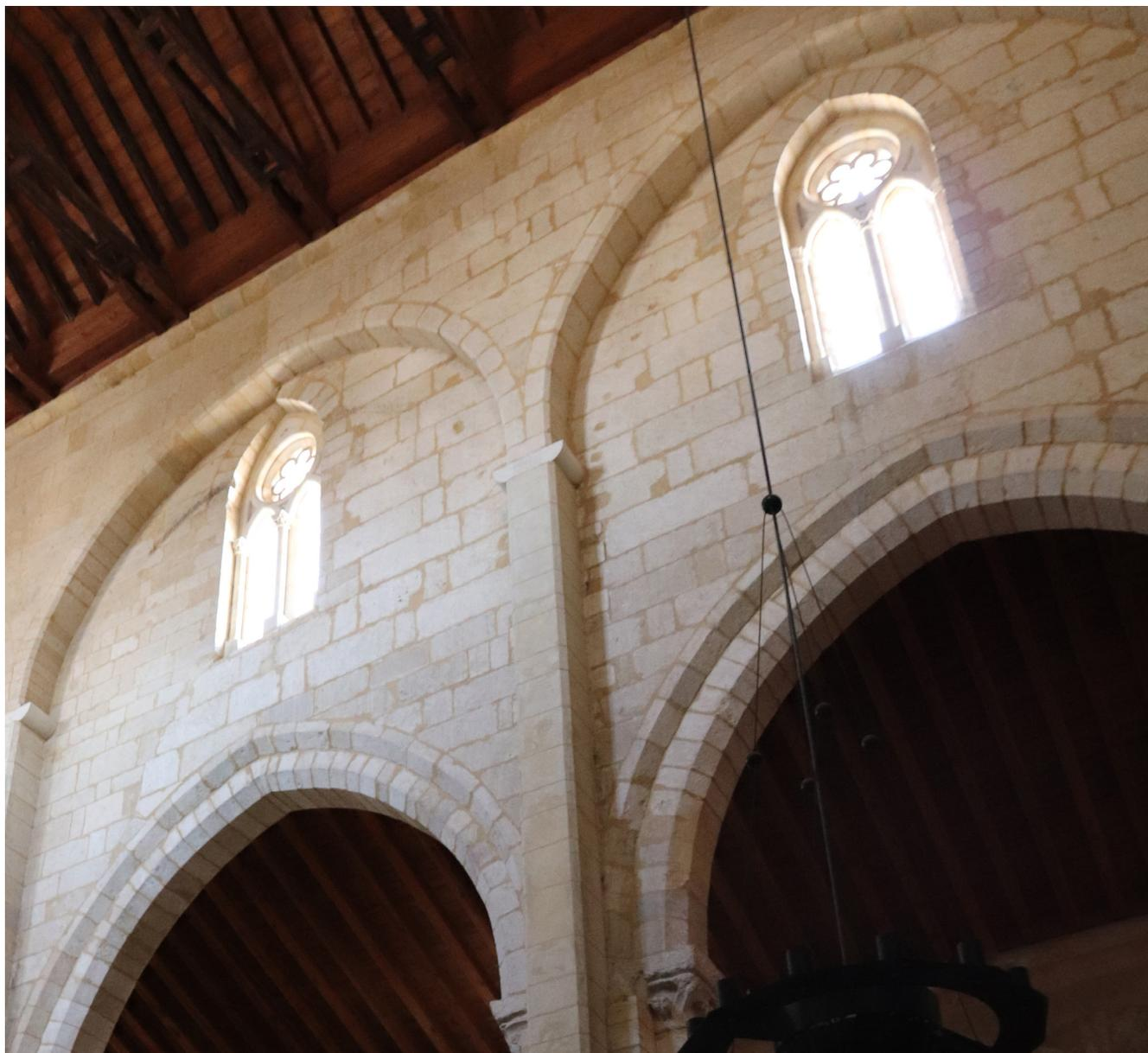
Figura 11. Hiatos constructivos en S. Pedro: contacto entre las arcadas inferior y superior con cambio de tonalidad de la piedra (a cota de la clave); desajuste en la ventana izquierda entre campañas constructivas; despiece autónomo de ventanas respecto al paramento (fotografía del autor).
