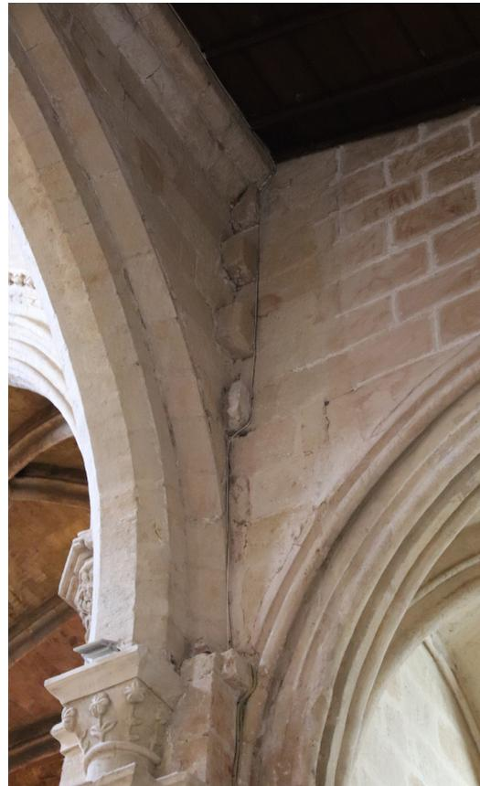
Figura 10. Adarajas en Sta. Marina para enlace con la arcada de la epístola y cornisa interior para cubierta lateral (fotografía del autor).
