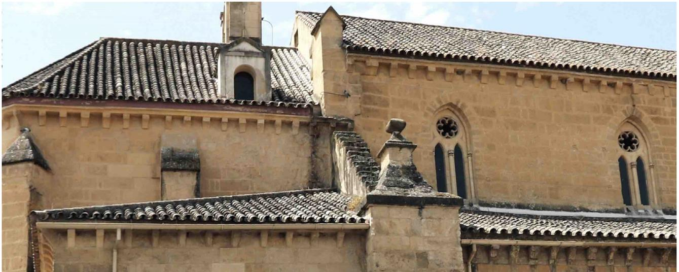
Figura 4. San Pedro: contrafuerte del ábside central recayente sobre la bóveda del ábside del evangelio y muro escalonado sobre su arco toral; también juntas de construcción en el pináculo de la capilla mayor y en la clave de segunda ventana de la nave central (fotografía del autor).
