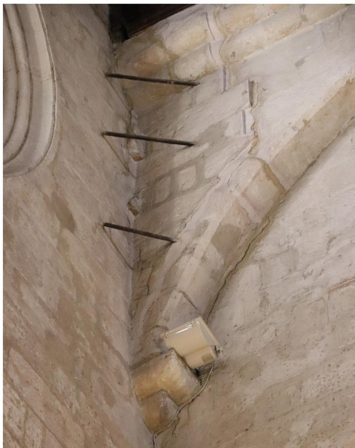
Figura 13. Arcada del evangelio de San Nicolás: adarajas para enlace con el hastial principal y para el arco superior (fotografía del autor).
