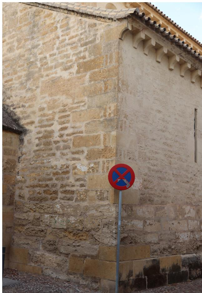
Figura 7. La Magdalena: zócalo inferior con sillares, esquinero de sillares de expolio, y alzado mural de sillarejo (fotografía del autor).
