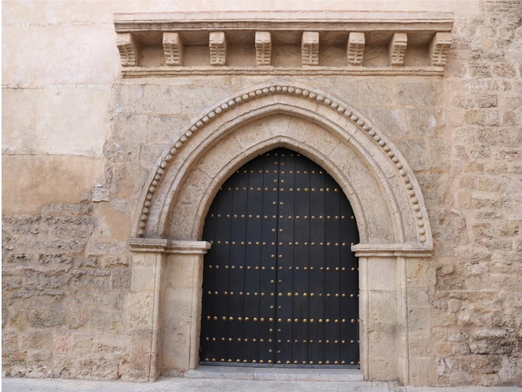
Figura 8. S. Lorenzo: portada lateral en sillería de la nave de la epístola, integrada en lienzo con distintas fases constructivas (fotografía del autor).
