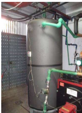
Ilustración 11: Depósito de Acumulación e Intercambiador
