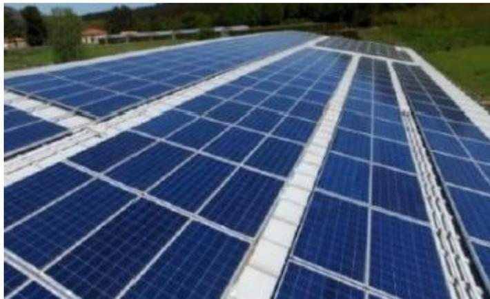
Figura 2: Ejemplo de estructura coplanar
