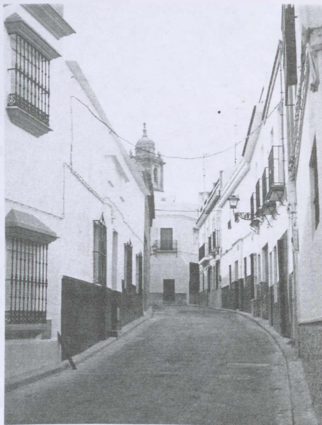
Calle Viljorado, actual Marques de Cádiz
