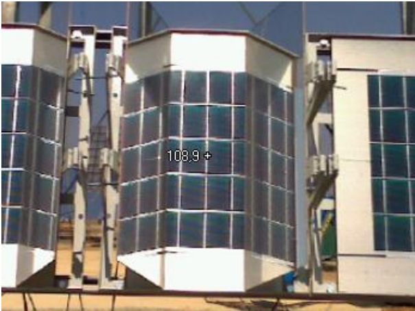
Ilustración 43. Fotografía del módulo Global Solar 2,2x tomada el 03/10
