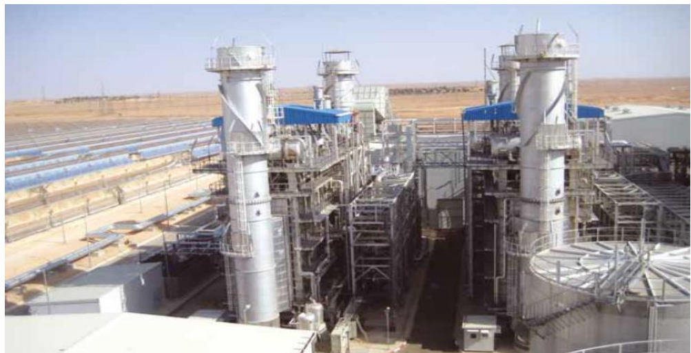
Figura 30: Vista del Ciclo combinado de la central HassiR'mel (28)
