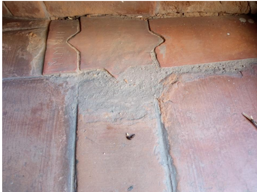
Imagen 10. Solería junto a la puerta con deyecciones de ave y una inscripción con números romanos. (MMXIII).
