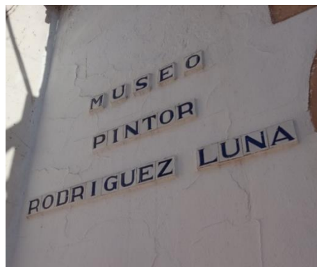
Imagen 3.2. Detalle azulejos ubicados en la fachada del edificio.
