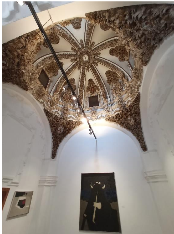
Imagen 2.1. Vista de la cúpula barroca con yeserías desde el interior del museo.
