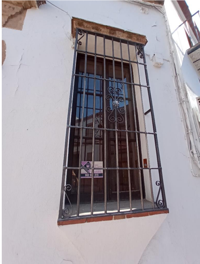
Imagen 5. Detalle del vano localizado junto a la puerta que da a la sala 1 del museo. Se contempla una reja de forja y un cartel sobre el vidrio de la ventana.
