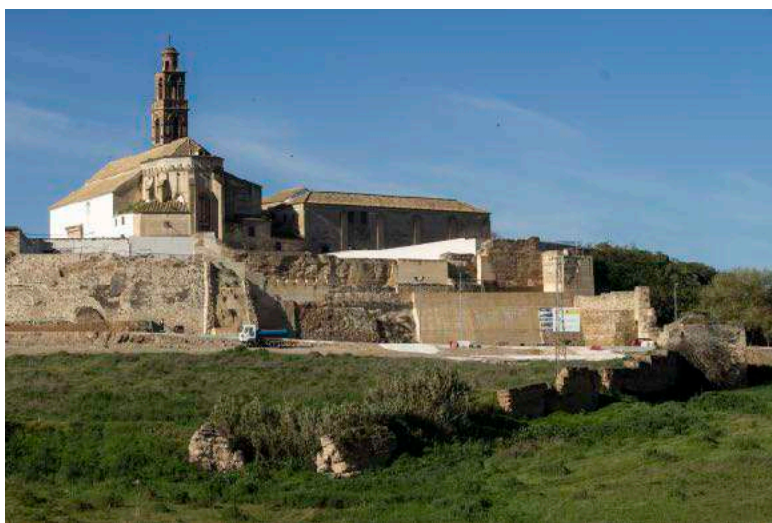
Figura 3. Labores de reacondicionamiento en la zona del Portillo (2021). Fuente: José Enrique Carmona Perea.
