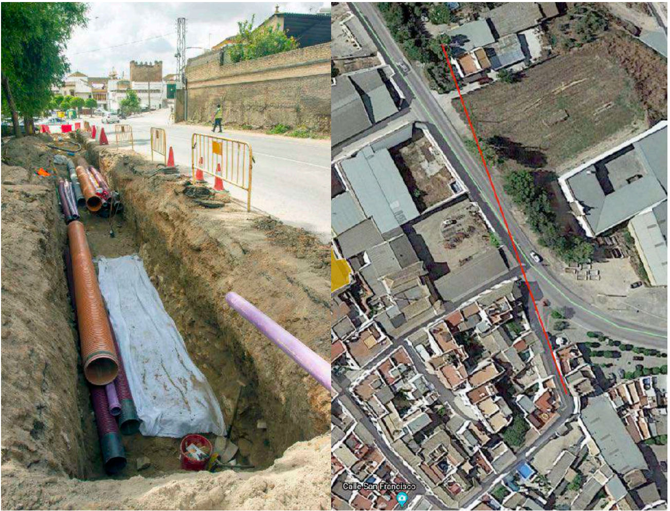
Figura 3A. Izquierda: Hallazgos realizados durante el proceso de construcción de la ciclosenda. Derecha: Trazado hipotético de la muralla encontrada durante la construcción de la ciclosenda (2021). Fuente: ACUPAMAR.
