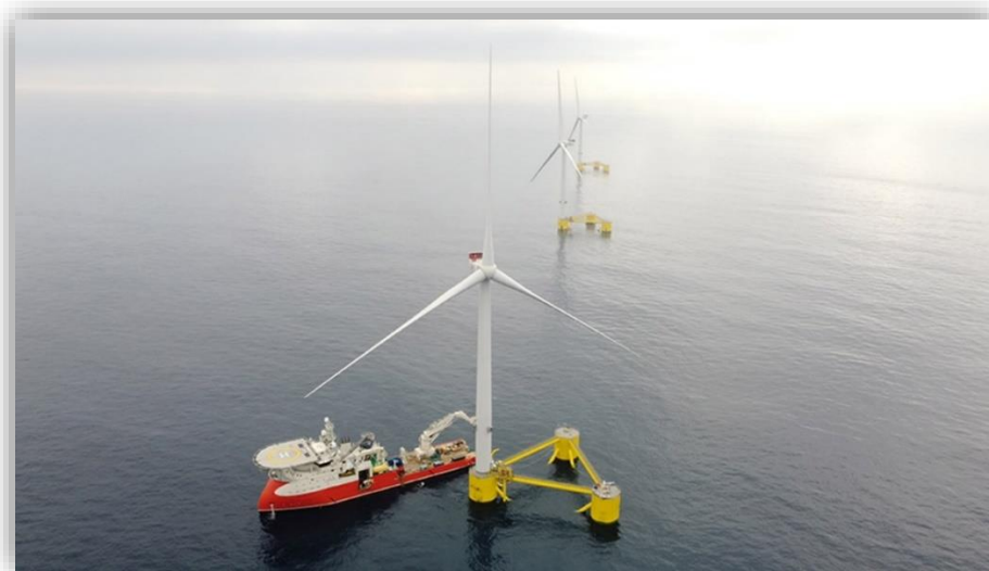
Figura 5.15. “Windfloat Atlantic”, el primer parque eólico flotante de Europa continental (Portugal)
