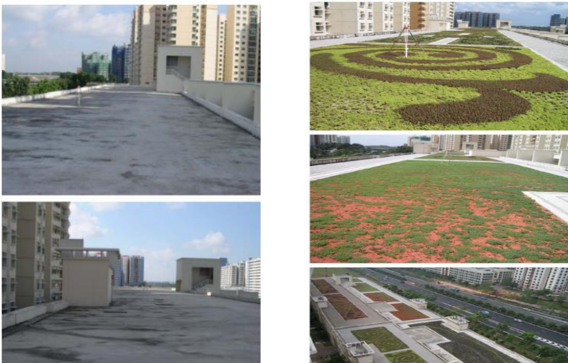
Figura 6. Instalación de cubierta vegetal. Antes y después. Fuente: W. Nyuk Hien, T. Puay Yok, & C. Yu, 2007
