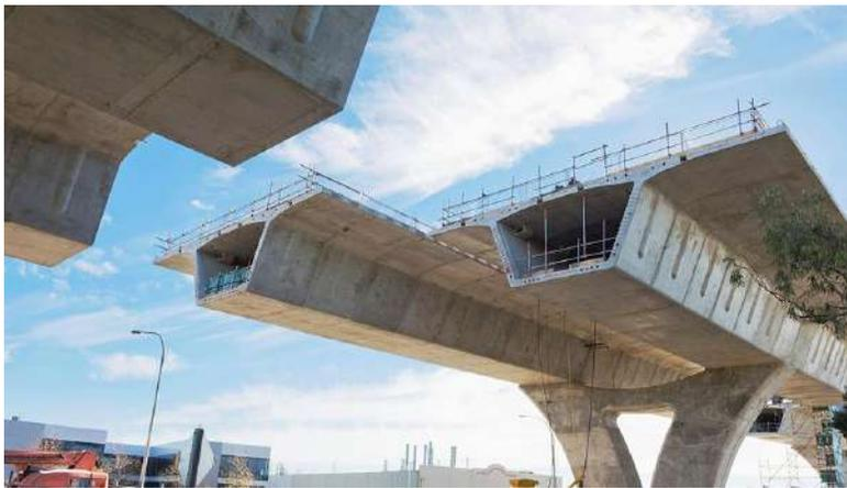
**IMAGEN 5:** Vigas artesas tradicionales de cajón simple en la construcción de puentes
