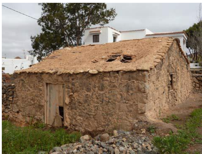
Fig. 19. Solución de cubierta en tierra en Las Palmas de Gran Canaria, Las Palmas (España). Fuente: [29]
