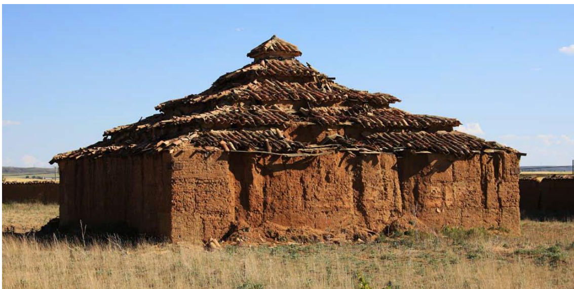
Fig. 7. Edificación mediante técnica de construcción por moldeado de muro monolítico de tierra apisonada (tapia) en Villanueva de los Caballeros, Valladolid (España). Fuente: [29]
