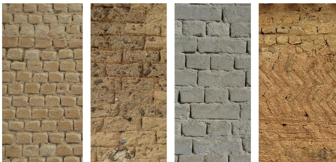
Fig. 16. Construcciones mediante solución constructiva de muro de fábrica de adobe con distintos aparejos (de izquierda a derecha): aparejo a tizón, aparejo a soga, aparejo a soga y tizón, y aparejo en espina de pez. Fuente: [29]
