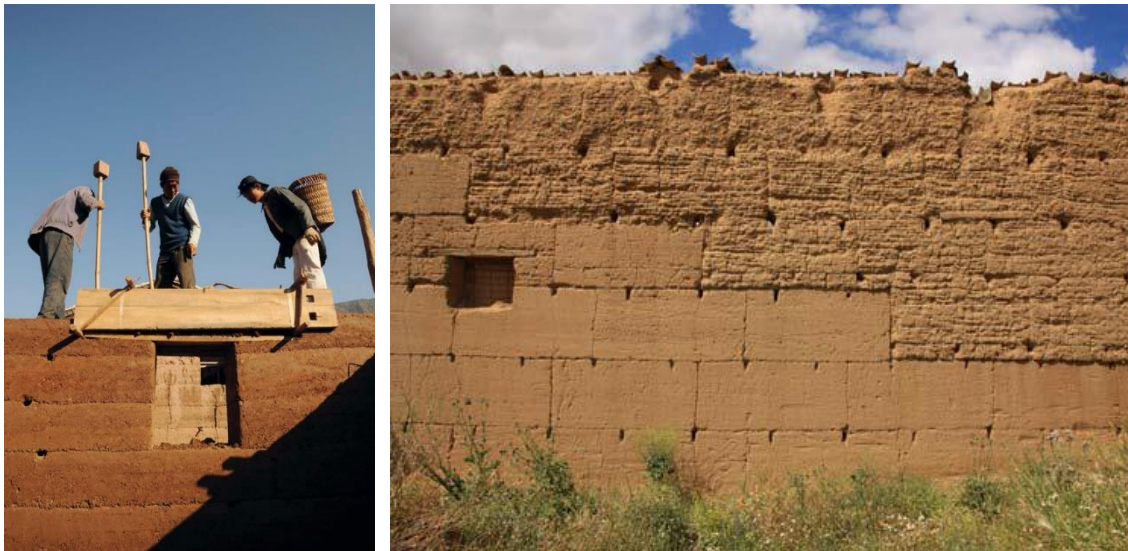
Fig. 15. Construcciones mediante solución constructiva de muro monolítico de tierra apisonada (tapia). A la izquierda: Obra en Pueblo de Maanqiao (Condado de Huili, Sichuan, China). Mu Jun. Fuente: [26]. A la derecha: Construcción en Barcial de la Loma, Valladolid (España). Fuente: [29]
