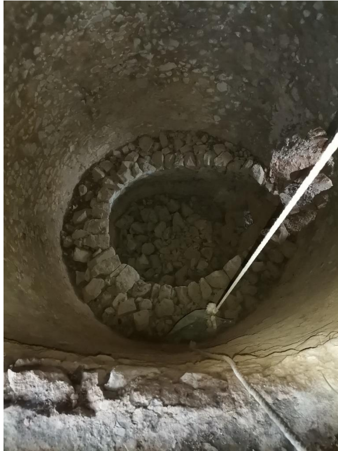
Figura 2.9. Interior del horno de cal durante el proceso de ahornado
