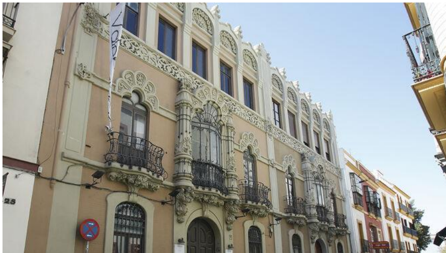
Figura 5.5. Edificio Modernista en la calle Alfonso XII, números 27 y 29 (1905-1906)
