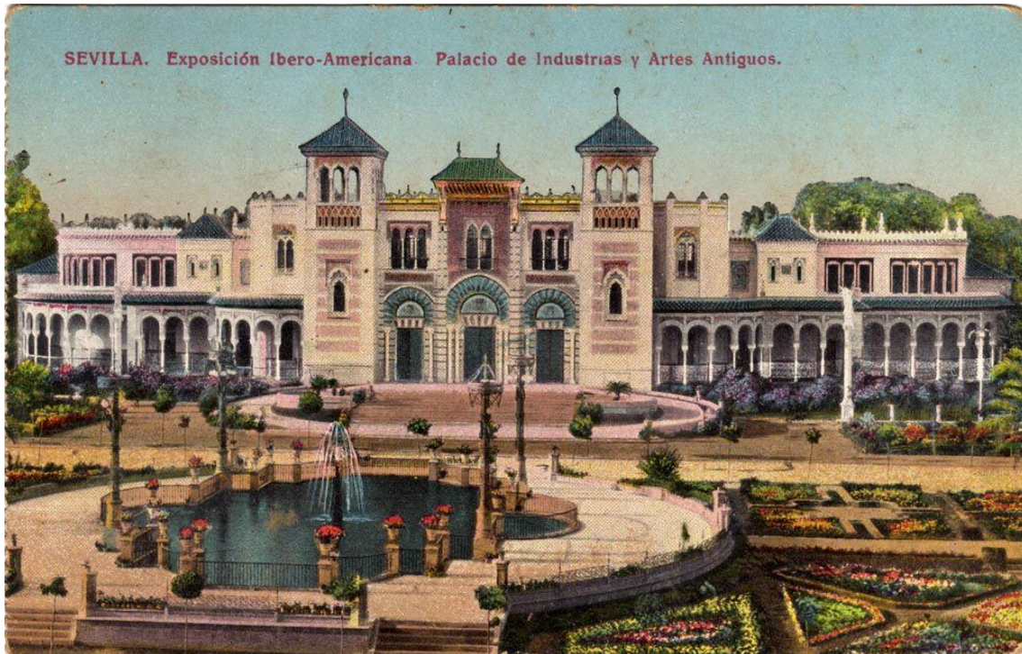
Figura 4.2. Postal del Pabellón Mudéjar y el Estanque.
