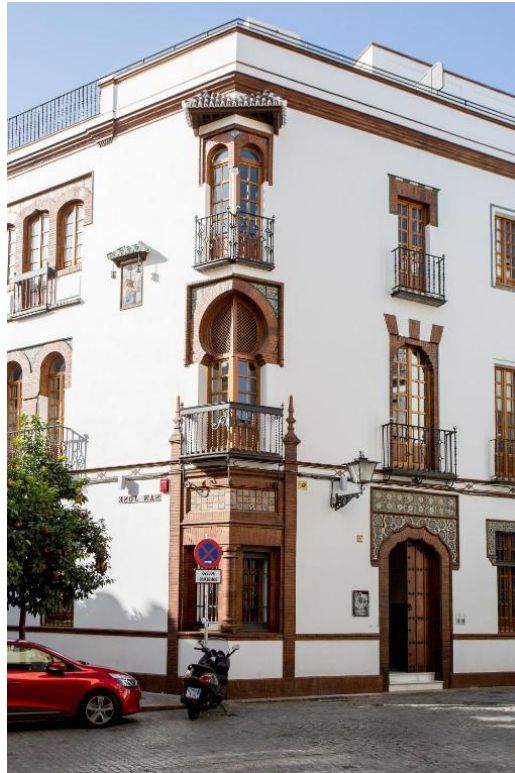
Figura 5.9. Casa Palacio Conde de Ibarra en la calle Conde de Ibarra, número 2 (1914)
