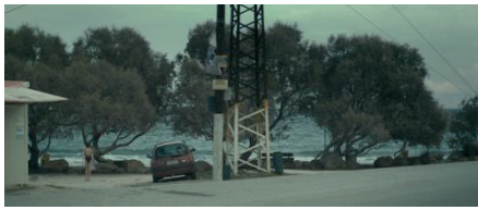
Figura 9. Poste de electricidad
