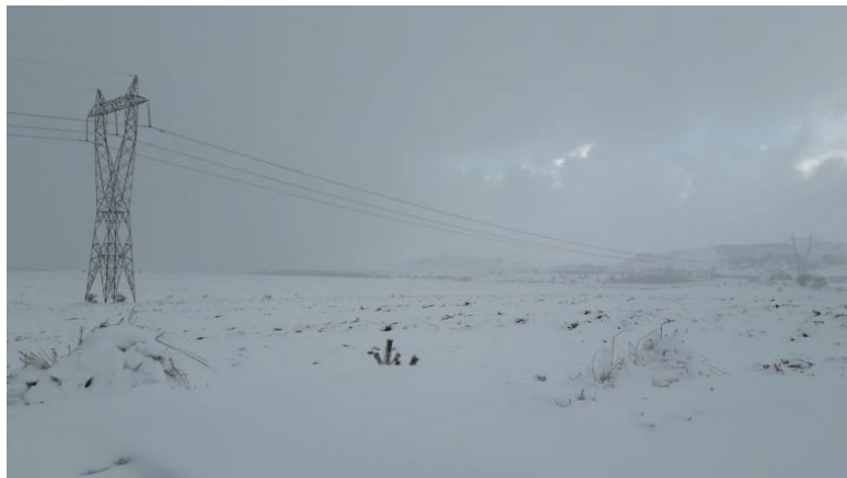
Figura 5. Estado del vano de la línea 400kV Herrera-Virtus (Palencia-Burgos) tras el temporal Helena (enero 2019). Fotografía extraída de [4].
