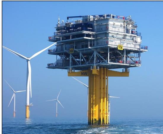
Figura 3-14 – Subestación eléctrica offshore
