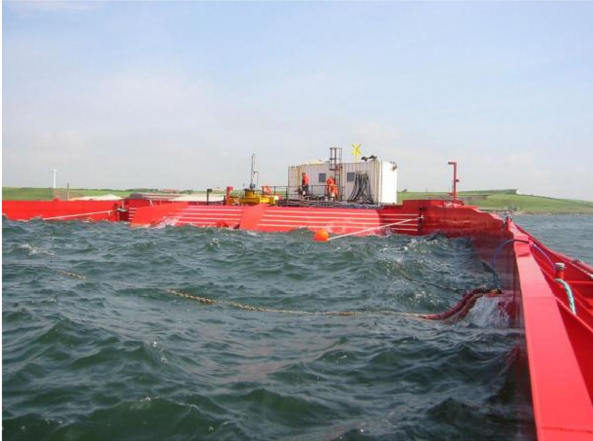
Figura 4-31. Sistema de desbordamiento flotante Wave Dragon
