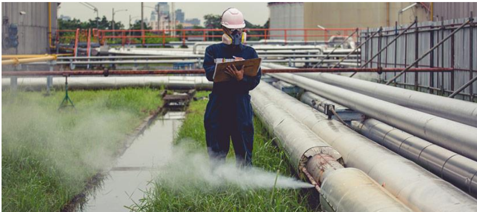
Figura 1-1. Localización manual de fuga peligrosa de gas en planta.
