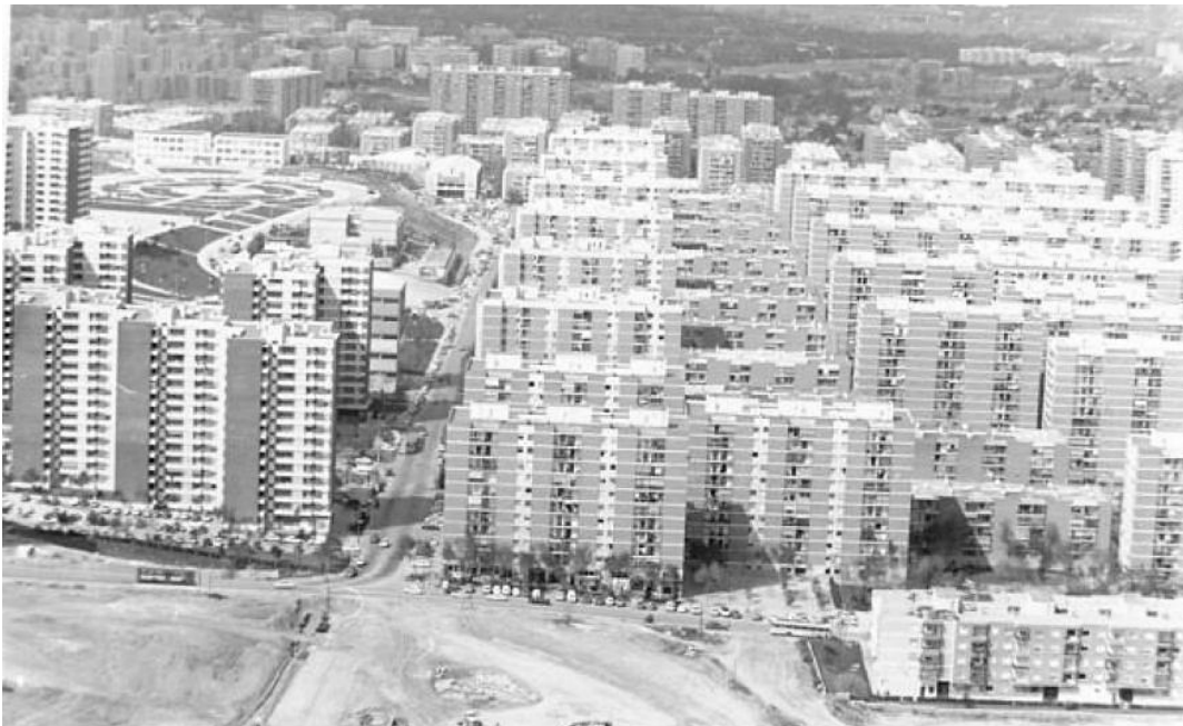
Imagen 2: Desarrollo urbano de las periferias. Barrio del Pilar. Madrid. Años 70
