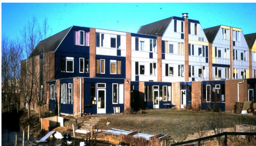
Imagen 13: Vista de Centraal Wonen Delft tras su construcción
