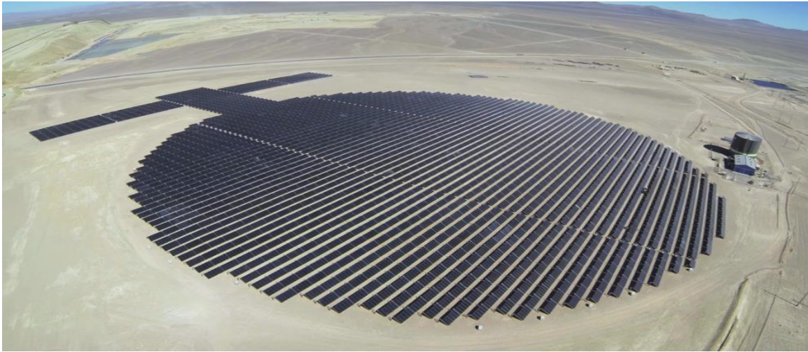
Figura 32. Instalación solar Codelco.
