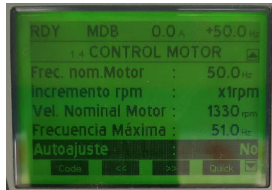
Figura 32. Ejecución de AUTOAJUSTE
