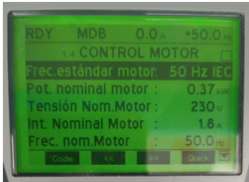
Figura 31. Insertar los parámetros del motor en el ATV71
