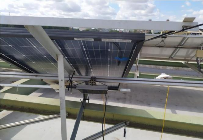
Figura 5-8. Nueva colocación del piranómetro y el panel que se dejó en el segundo montaje
